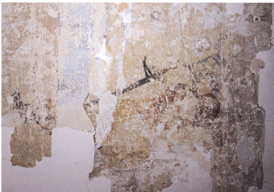
Fig. 14 Premier étage ouest, mur nord, personnage couché peint à partir de 1557/1558
