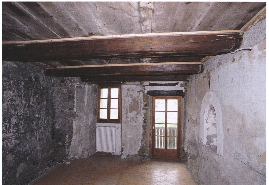
Fig. 11 Rez-de-chaussée ouest, pièce donnant sur la Sarine, avec sa poutraison de 1557/1558
