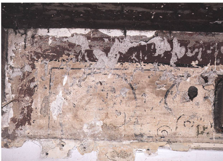
Fig. 16 Premier étage ouest, mur nord, vestiges du troisième décor à bandeaux rouge sang-de-bœuf réalisé entre la fin du XVI e et la première moitié du XVII e siècle (en dessous : traces du premier décor)
