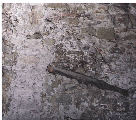
Fig. 5 Combles, mur mitoyen nord, chevron de 1259
