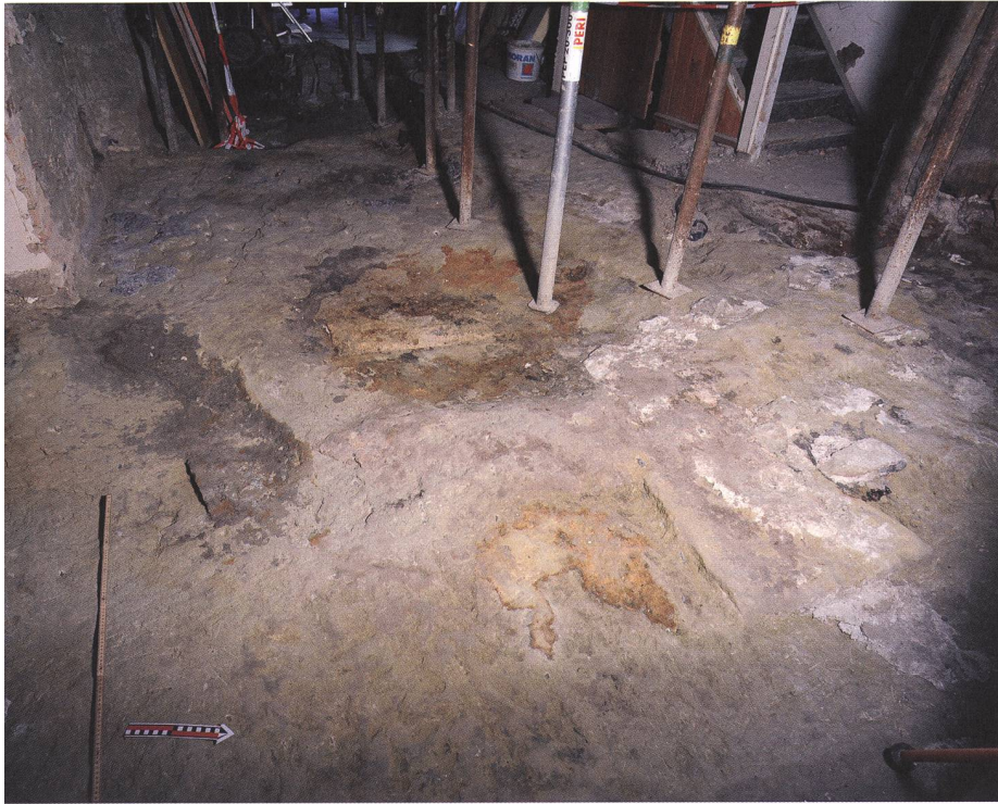
Fig. 21 Rez-de-chaussée, foyer et traces de cloisons au centre de la maison, après 1529 ?
