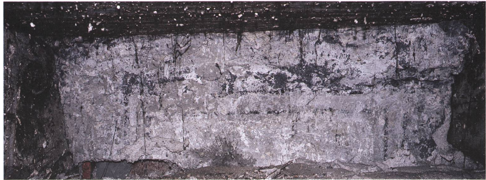
Fig. 8 Rez-de-chaussée, restes du décor peint du couloir réalisé à partir de 1529/1530
