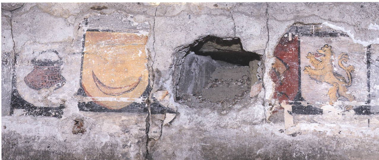
Fig. 15 Premier étage ouest, mur nord, frise d'armoiries peinte après 1557/1558, d'ouest en est
