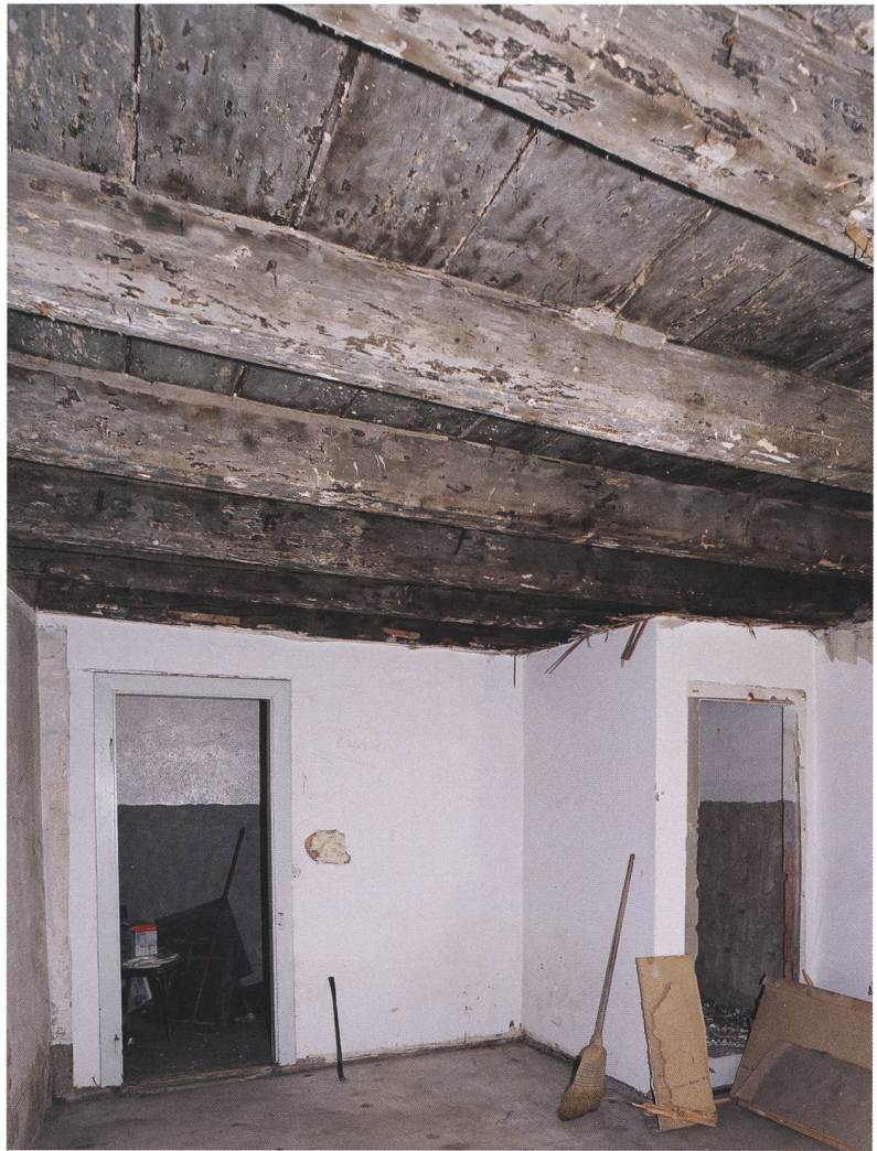
Fig. 7 Rez-de-chaussée, plafond de la boutique ou de l'ouvroir, 1529/1530
