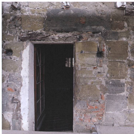
Fig. 10 Façade ouest, rez-de-chaussée, vestiges de la porte d'accès à la galerie, 1557/1558
