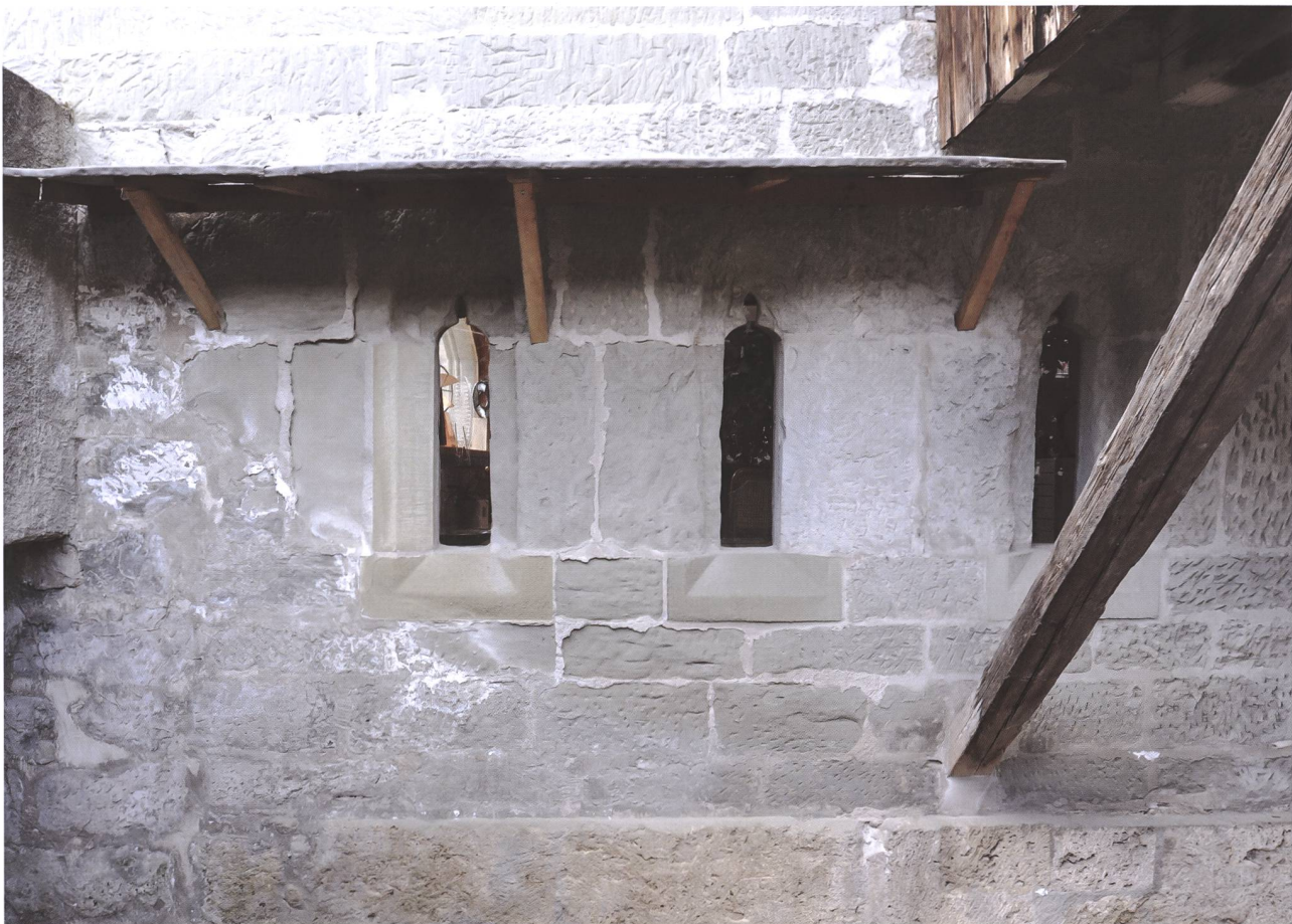
Fig. 9 Fentes d'éclairage trilobées de 1251-1267 au rez-de-chaussée de la façade orientale de la rue d'Or 25
