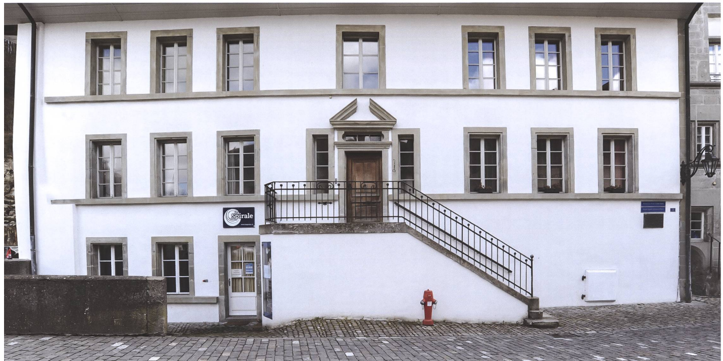
Fig. 7 Place du Petit-Saint-Jean 39, façade nord après les travaux
