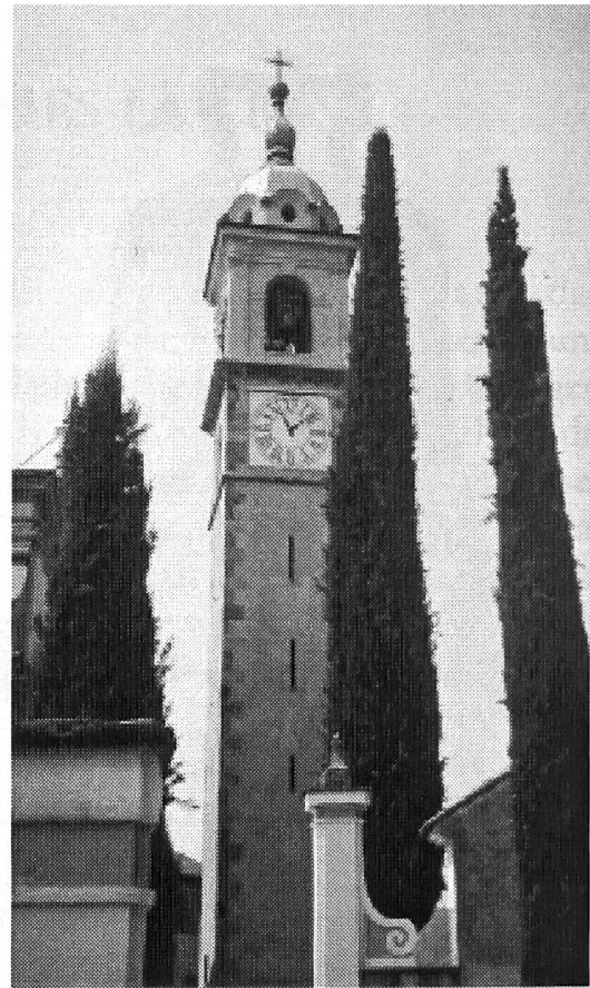
Abb. 4 - Die Bauweise der schlanken Campanili (hier Pfarrkirche Gentilino) erklärt die Wahl des Aufhängungssystems mit fallendem Klöppel aus statischen Gründen.
