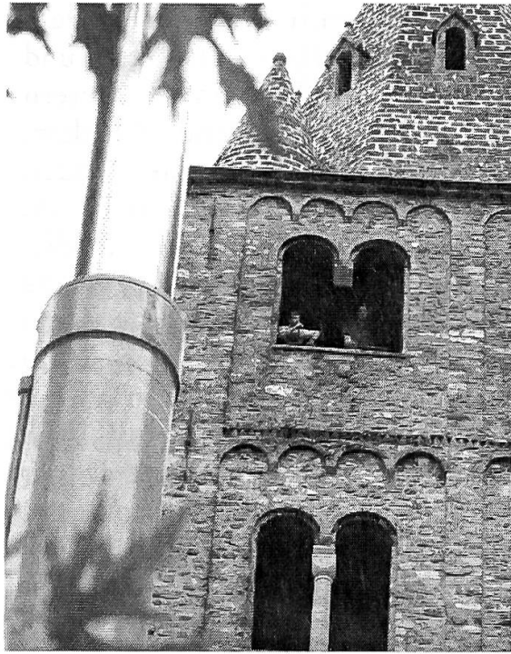
St-Maurice : une colonette fut provisoirement enlevée pour permettre l'entrée des cloches
