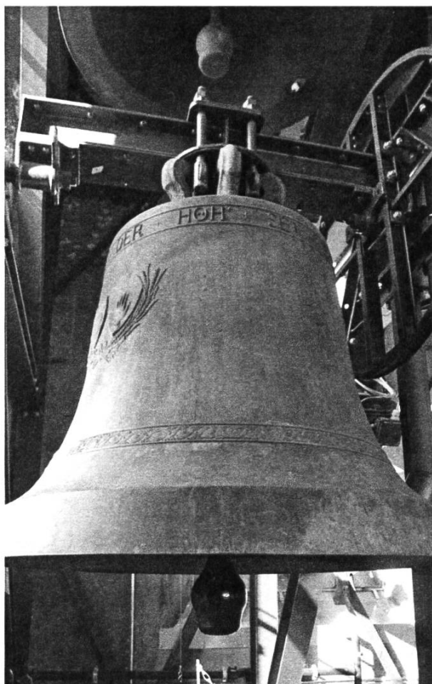
Abb. 8: Lenzburg, ref. Stadtkirche. Glocke es' mit neuem Klöppel von 2016, der zeigt, wie der Vorschwung bei einem geraden Stahljoch gänzlich aufgelöst werden kann. – Foto: Autor.
