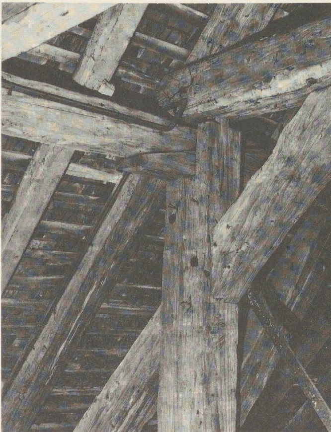
Figure 19 Joint en sifflet, raccord de la charpente à la croupe polygonale.
