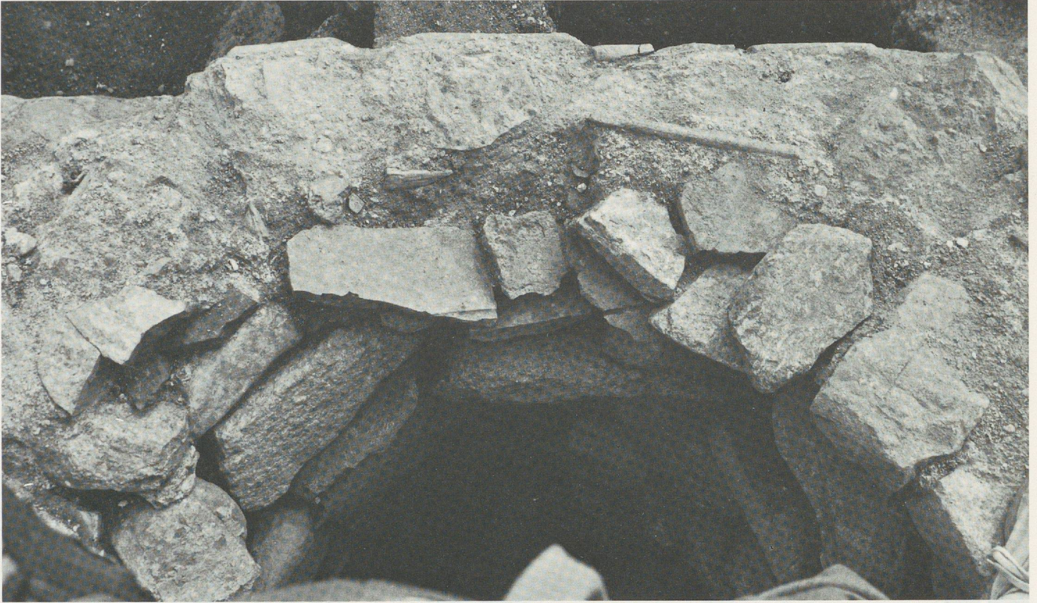
Fig. 139. Bât. est : margelle du puits (st. 122), vue verticale.
