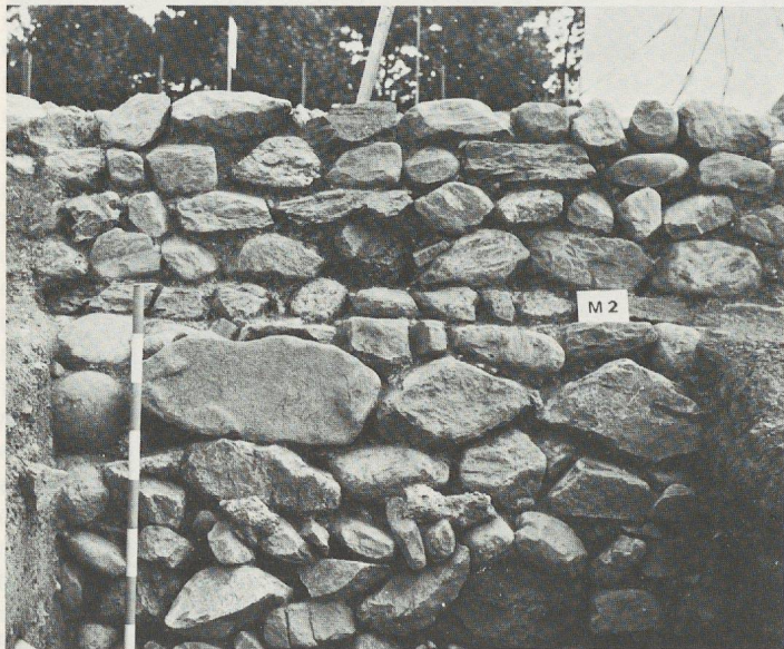
Fig. 119 Bât. est : parement sud du mur M2, vue nord.
