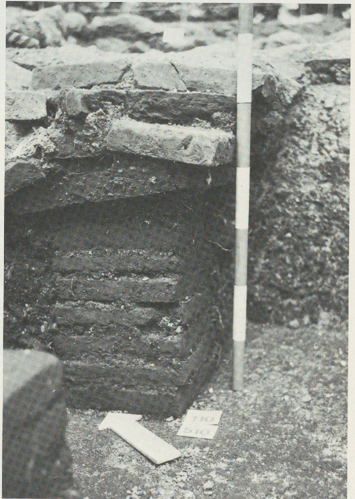
Fig. 137. Bât. est, pièce P2 : pilette de soutènement du sol (st. 5) dans le canal central de chauffe (st. 6), vue nord.
