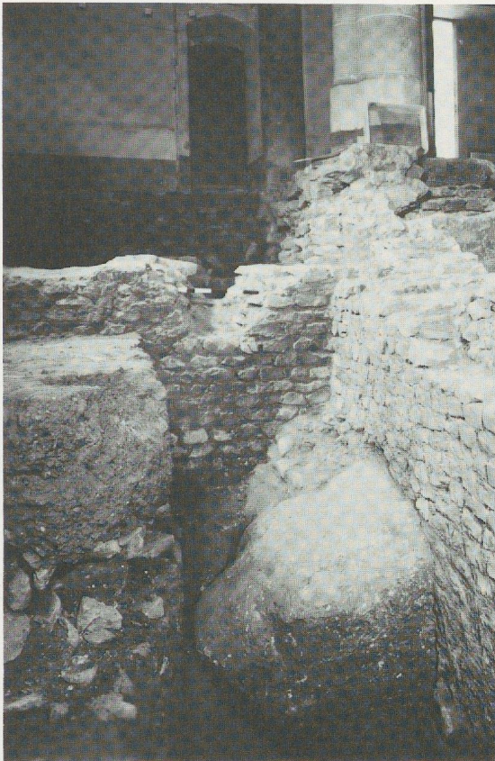
Fig. 7: Vue du mur gallo-romain, fondé en partie sur la roche, avec son fruit
