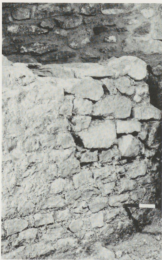
Fig. 23. Le bouchon du couloir côté sud
