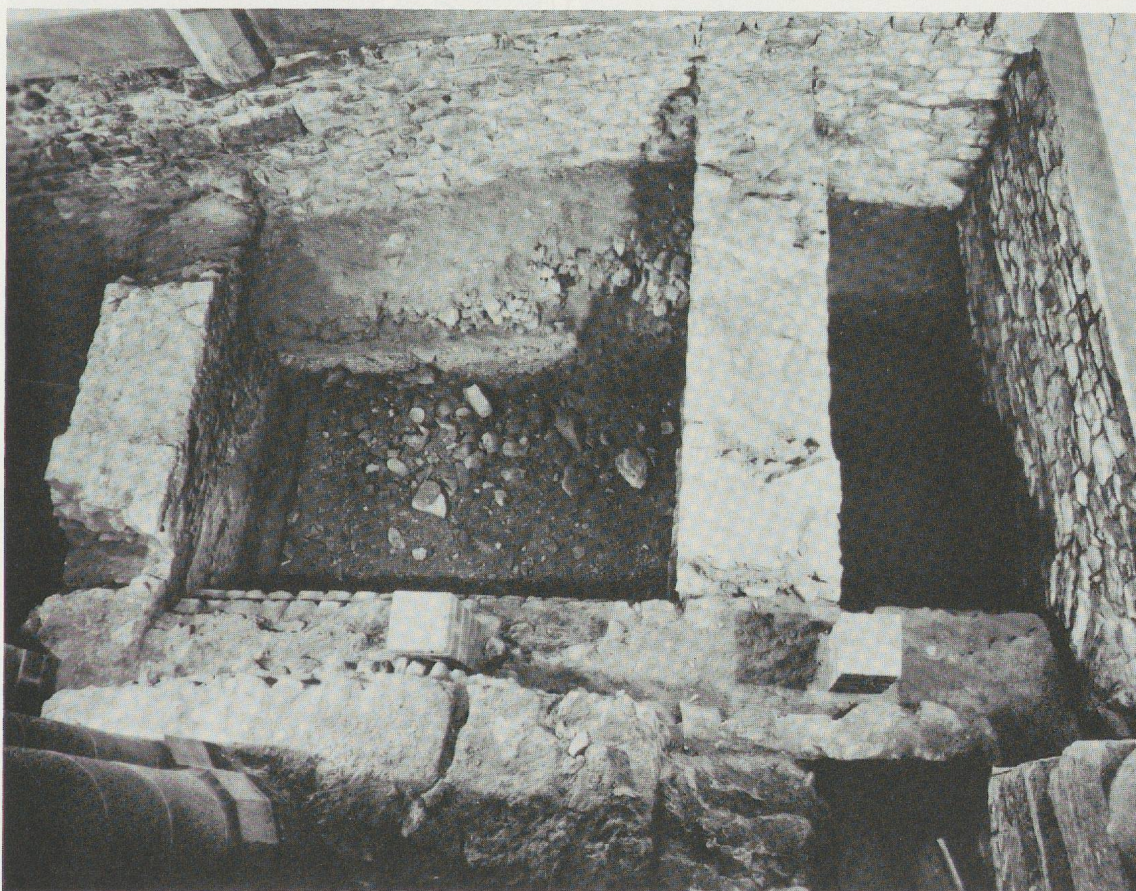
Fig. 46: Vue des fondations de l'ancien clocher
