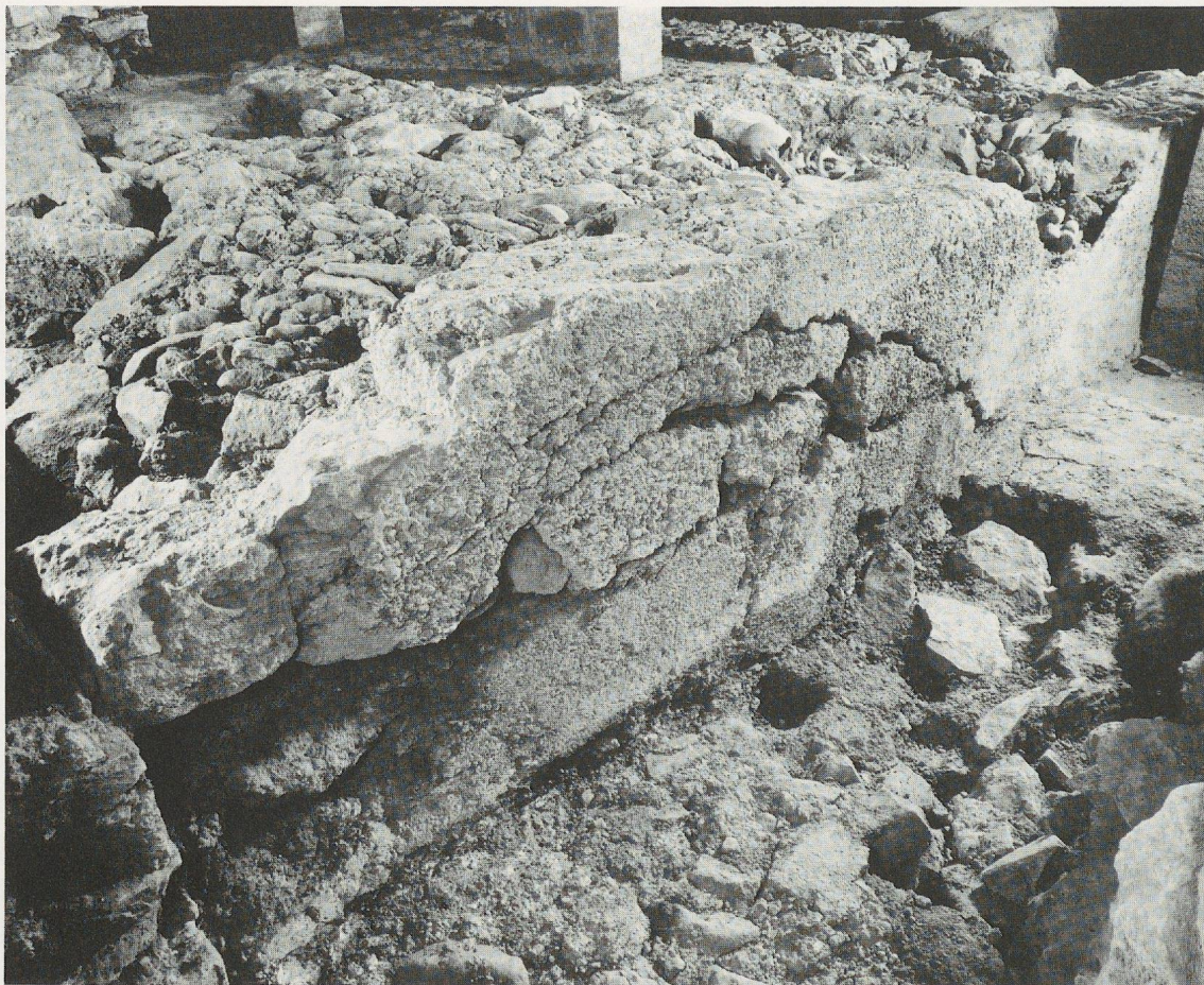
Fig. 22. Vue du couloir
