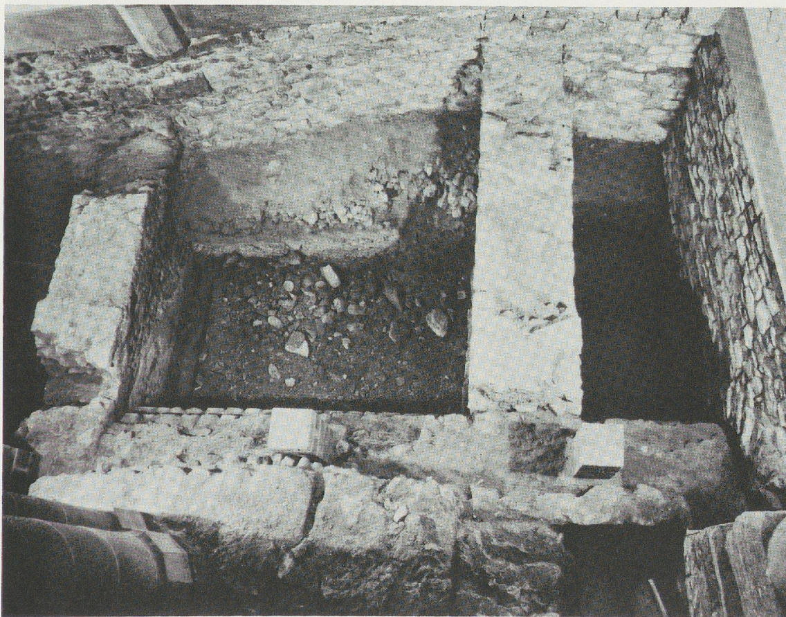
Fig. 46: Vue des fondations de l'ancien clocher
