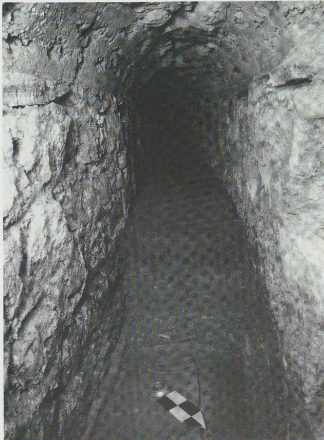
Fig. 52. Vue intérieure de l'égout st.39.
