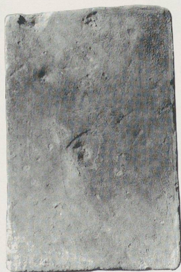
Fig. 117. Tuile à découpe droite percée d'un trou au centre, près du bord supérieur, afin de permettre son accrochage à la latte (provenance inconnue).
