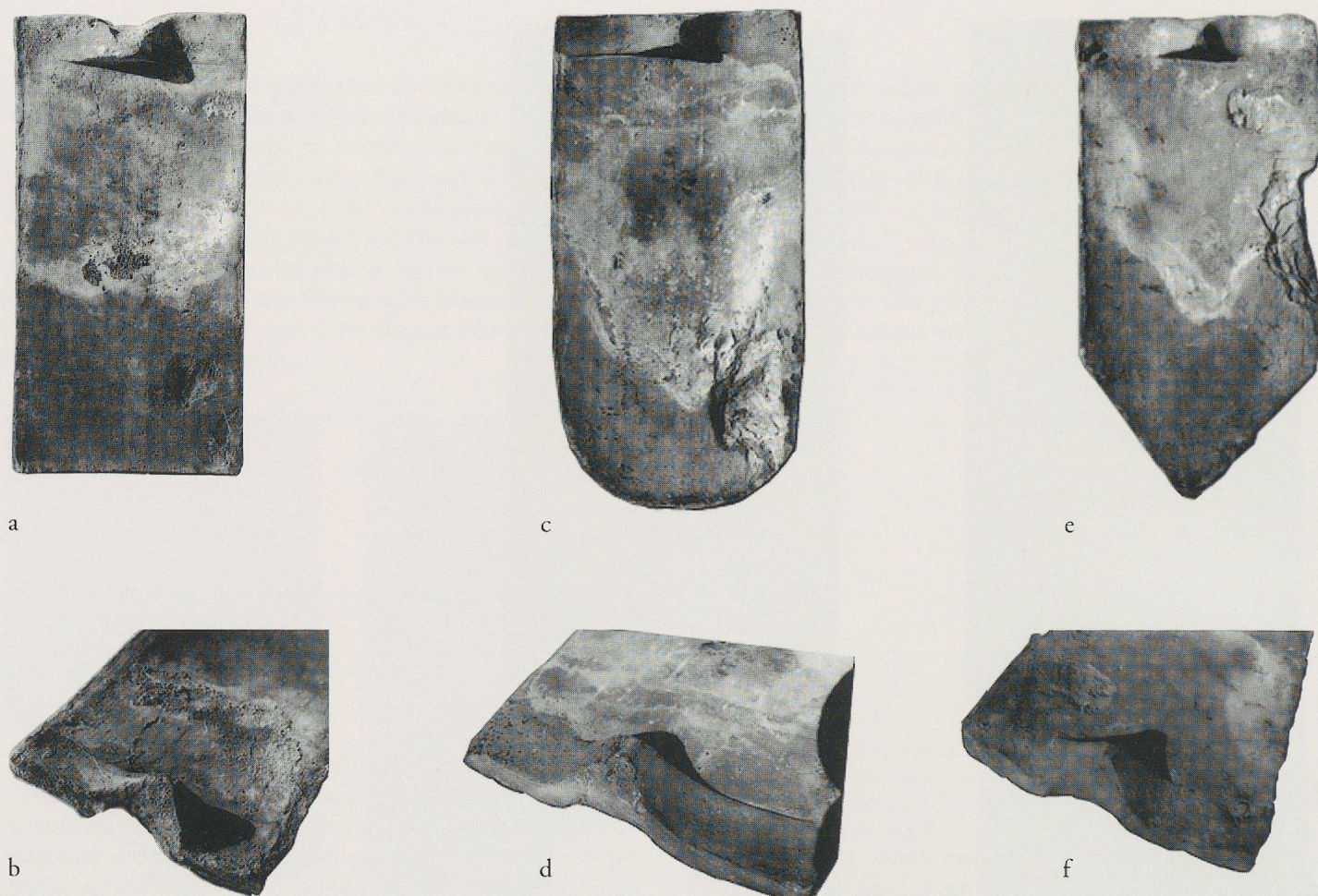
Fig. 122a-f. Tuiles moulées «à la française» caractérisées par des formes différentes de découpes, droite (a-b), en anse de panier (c-d) ou encore pointue (e-f), mais toutes pourvues du même type de talon, de forme triangulaire et rabattu (a-b. Cully, place du Temple 15; c-f. Romainmôtier, église).
