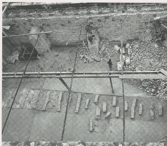
Fig. 33. Le premier mur VI 1 de la terrasse est en cours de démolition, avec la dernière assise de boutisses.
