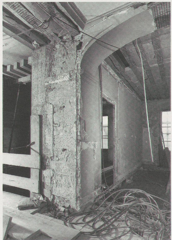
Fig. 43. L'encadrement de porte à l'extrémité du mur de refend de l'aile nord au premier étage du château.
