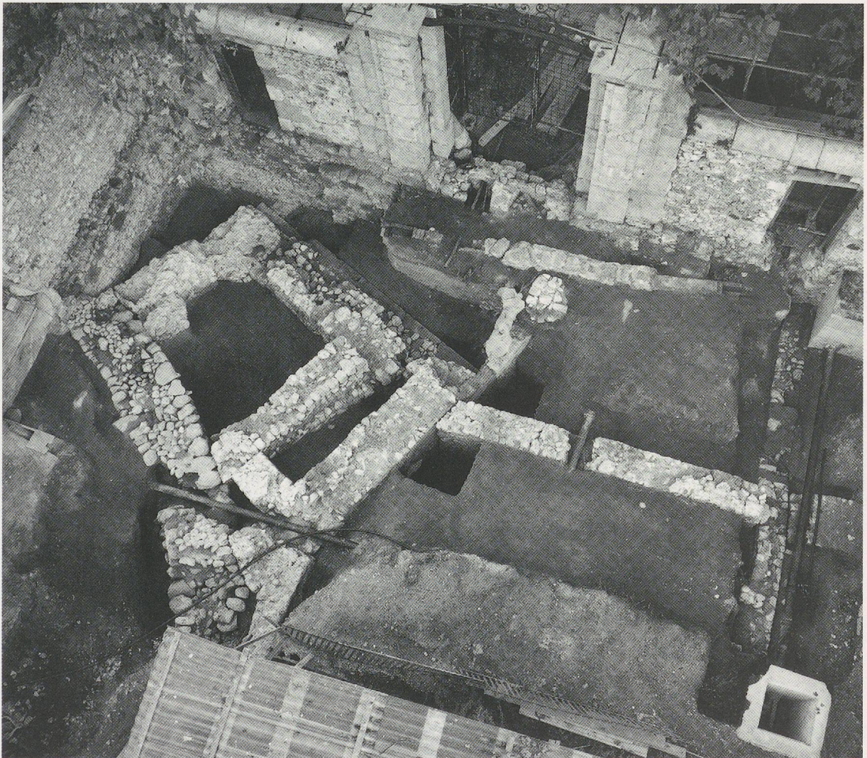
Fig. 23. Vue aérienne du secteur de l'entrée.
