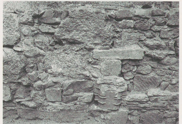
Fig. 46. Bloc en remploi dans la fondation du château (voir aussi fig. 86).
