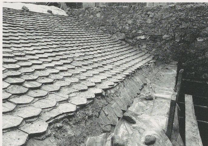
Fig. 69. Détail du pan sud de la serre souterraine.
