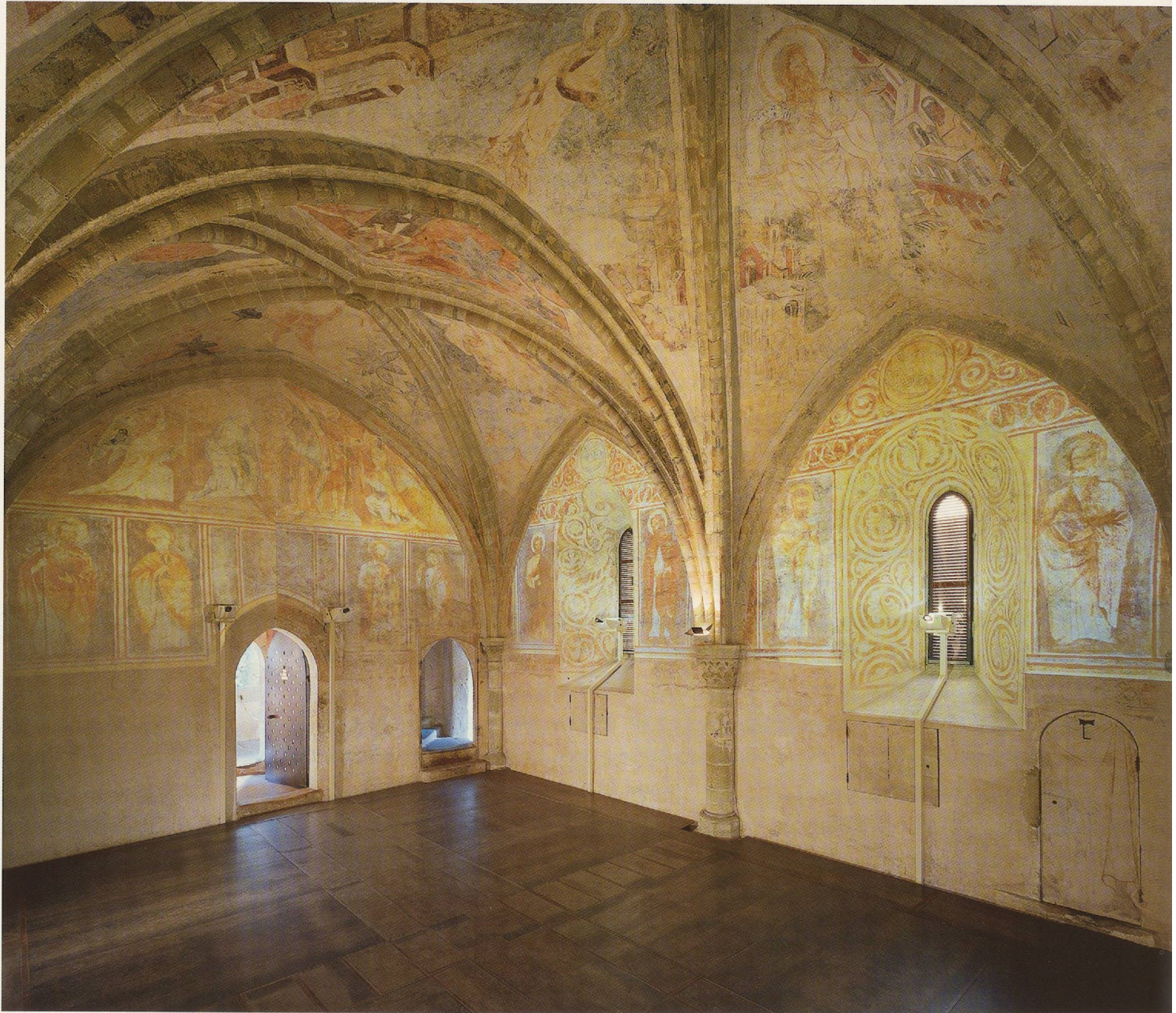
▲ Fig. 1 La chapelle Y après restauration, avec projections lumineuses, vue en direction du nord-ouest, vers l'entrée et vers l'escalier conduisant à la camera domini .
