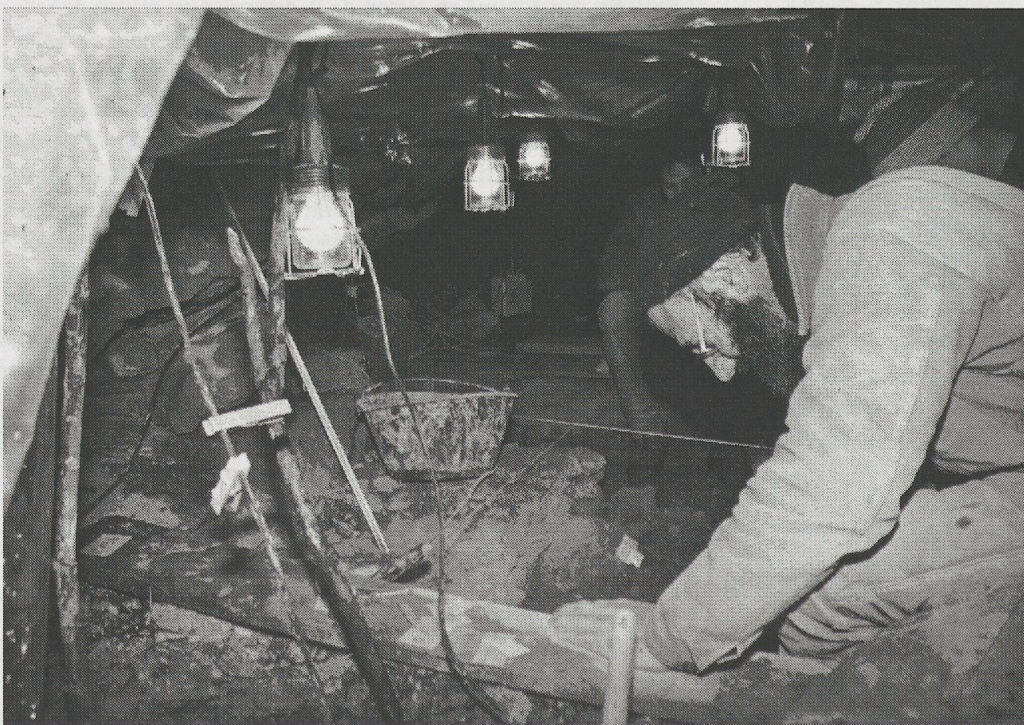
Fig. 2. Chantier de fouille.
