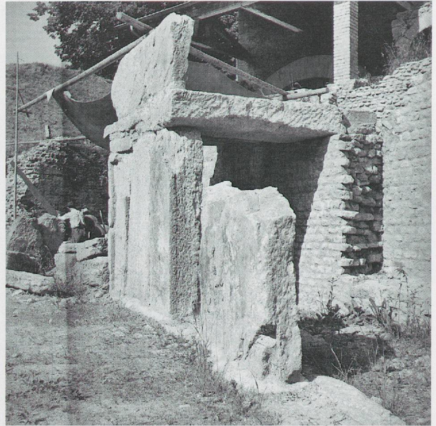
Fig. 32. Reconstitution de l'extrémité est du couloir de service, au débouché de l'escalier du couloir N. Ses dalles de couverture fonctionnent comme déambuloire à la base des gradins et sont bordées d'un parapet. 6 juin 1950.
