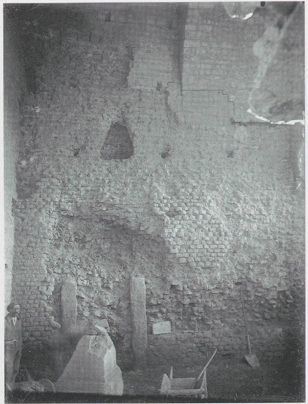
Fig. 20. Mur sud du passage axial M: au-dessus de la porte L, encore comblée de remblais et privée de linteau, cheminée de tirage du four à chaux installé tardivement dans le vestibule P adjacent; à droite en haut, naissance de la deuxième voûte en partie restaurée à l'intrados. 1919 (?).
