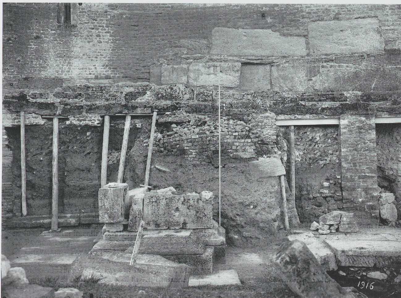
Fig. 17. Le piédroit nord du passage C, partiellement effondré, avec son canal de drainage, vu de l'est, le 9 janvier 1915.
