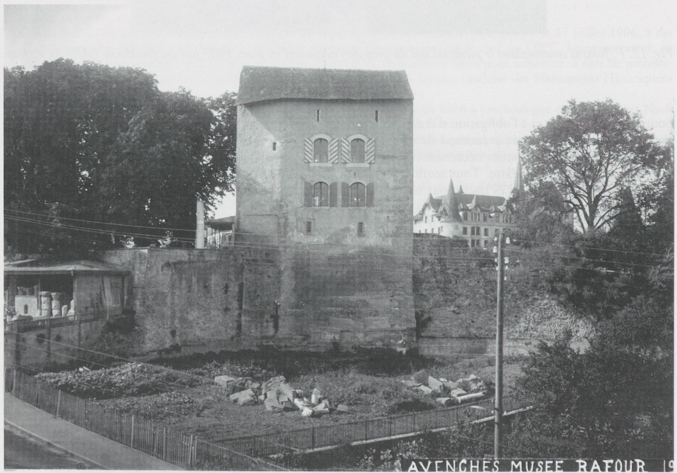
Fig. 14. La tour du Musée et le Rafour vues de l'est en octobre 1911.
