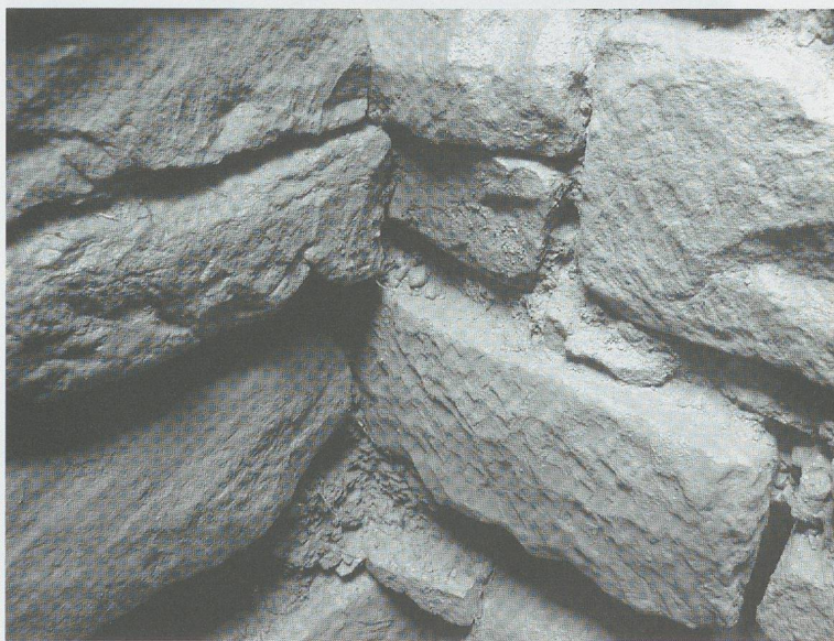
Fig. 9: Détail du parement du puits n° 2 du Barbarakopf, avec traces d'outils. (Cliché S. Fichtl).
