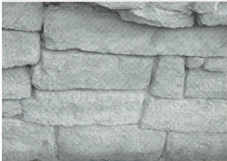
Fig. 3: Détail du parement en grès rose taillé du Fossé des Pandours. (Cliché S. Fichtl).
