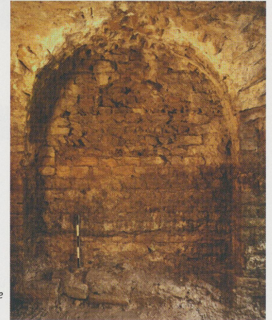
Fig. 131 (à dr.) La niche St 95 située dans la galerie de service souterraine. Vue ouest.
