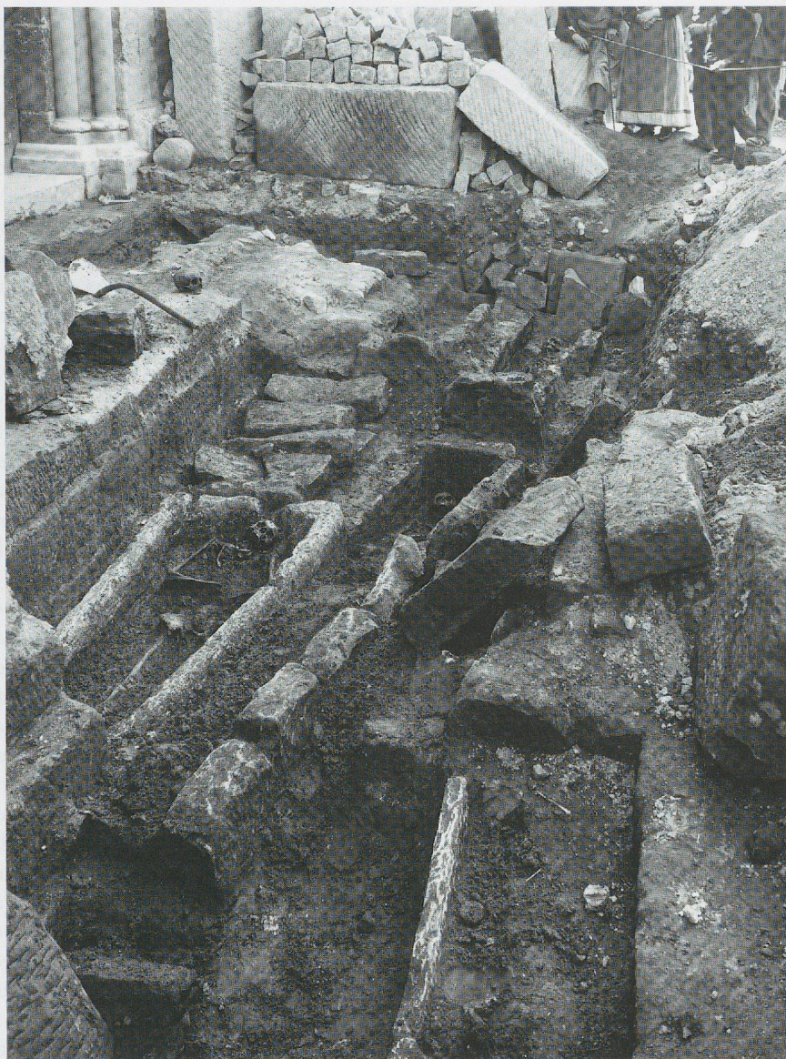
Fig. 5. Fouilles dans le cloître, au nord de la porte du transept, 1904.
