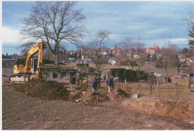
Abb. 30 TRA 1999.1, Aushub Bagger Sondierung S25.
