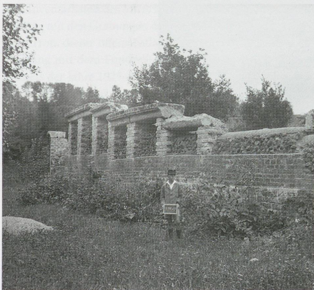
Abb. 20 Konservierte Peripheriemauer NE mit aufgesetzten Gesimsquadern (1927).
