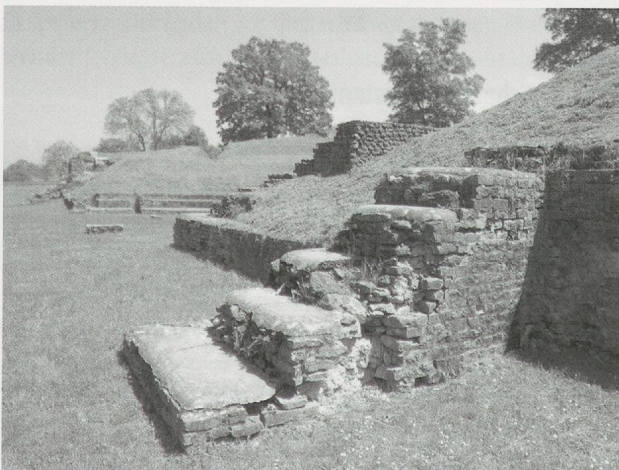
Abb. 6 Schäden an M 93. Blick von W.
