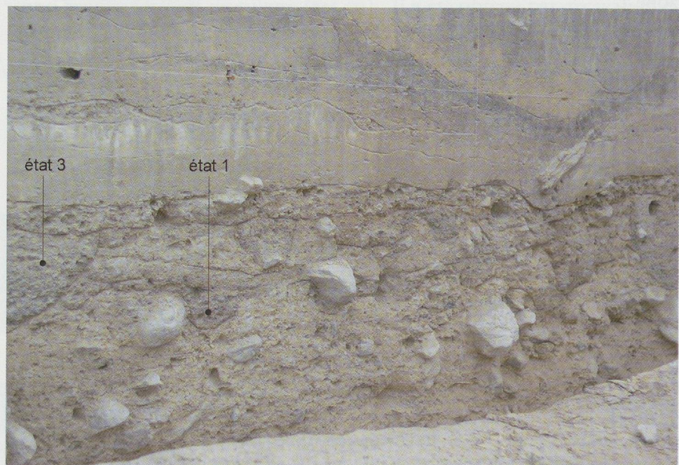
Fig. 115 — Zone 2, section 1. Négatifs des rondins porteurs du premier état de la voie. Les négatifs de plus grandes dimensions aménagés au dessus (premier plan à gauche) correspondent à la structure porteuse de l'état 3. Vue depuis l'ouest.
