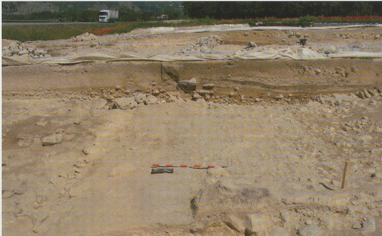
Fig. 112 — Zone 6. Le replat aménagé pour la voie (sous le jalon) atteint à cet endroit 6 m de largeur. Vue depuis le sud-ouest.
