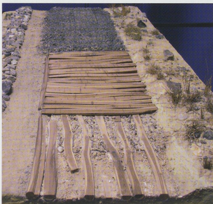
Fig. 149 — La maquette présente un arraché des éléments de la route romaine : au premier plan, la fondation constituée par les rondins porteurs et le remblai de fascines, puis par-dessus, le tablier et la recharge de graviers.
