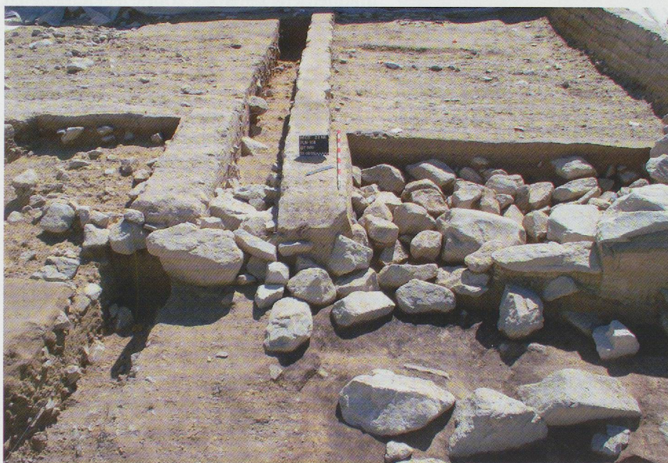
Fig. II6 — Zone 2. Accotement empierré aménagé à travers le talweg fossile, destiné à stabiliser la voie (état 1). Vue depuis l'ouest.
