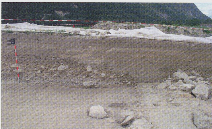
Fig. 196 — Zone 2, bisse 4 vu en coupe (STG 26). Les lits du bisse se sont régulièrement décalés vers l'amont pour maintenir la courbe de niveau et compenser la sédimentation générée par ses propres débordements. Vue depuis le nord-est.
