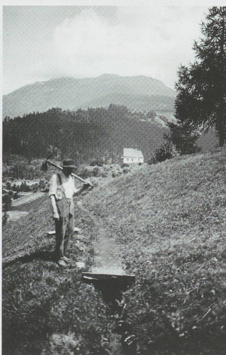
Fig. 207 — Ecluse placée à travers le cours du bisse pour le faire déborder. Bisse de Mühlebach, vers 1920 (Rudolf Zingeller).
