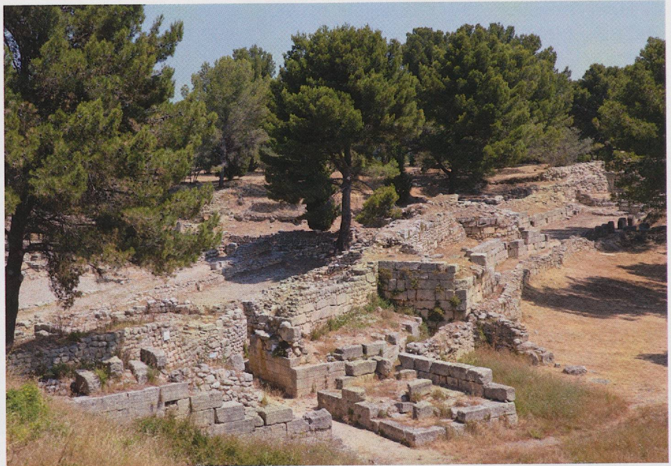
Fig. 10 — Les fortifications de l'oppidum de Saint-Blaise (Saint-Mitre-les-Remparts).
