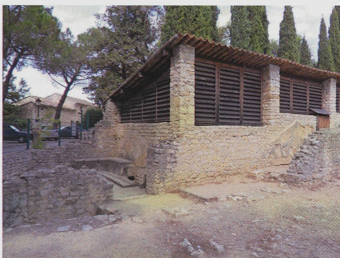
Fig. 5 — Maison à la Tonnelle. Toiture de protection avec volet à claire-voie.
