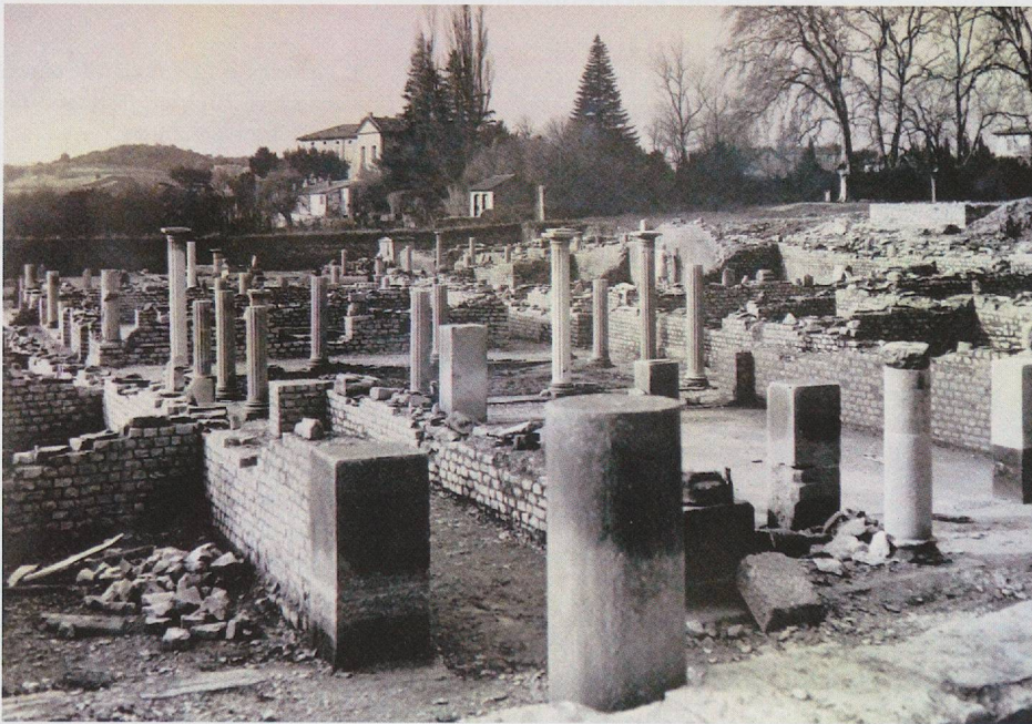
Fig. 1 — Maison du Buste en Argent après restauration en 1938.
