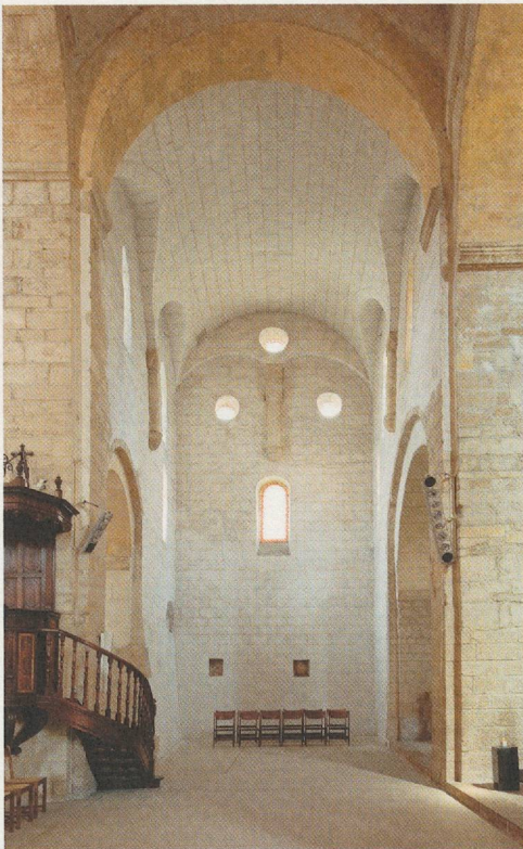
FIG. 27 — Le croisillon nord du transept
