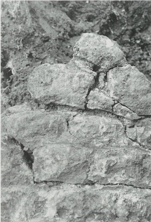
Fig. 71. Portique nord du péribole. Le mur intérieur de la rotonde. Détail de l'appareil impliquant l'existence d'un arc.
