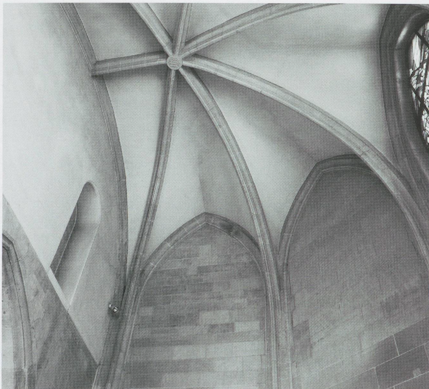
Fig. 8. L'église Sainte-Marie-Madeleine à Genève. La chapelle Saint-Michel de Michel de Fer, 1448-1451: nervures et supports à profils continus du côté nord (photo MG, 2013).
