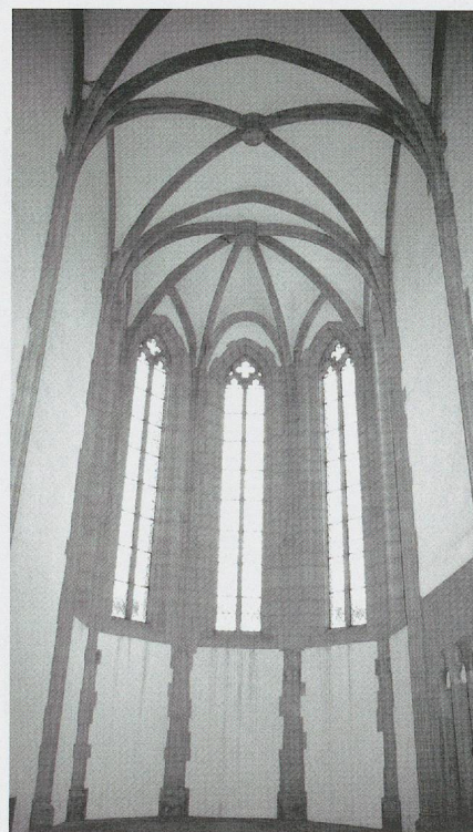
Fig. 9. L'église du couvent de Saint-Jean d'Erlach BE. L'intérieur du chœur gothique (vers 1390-1395), remonté en 1970-1971 (photo MG, 1985).
