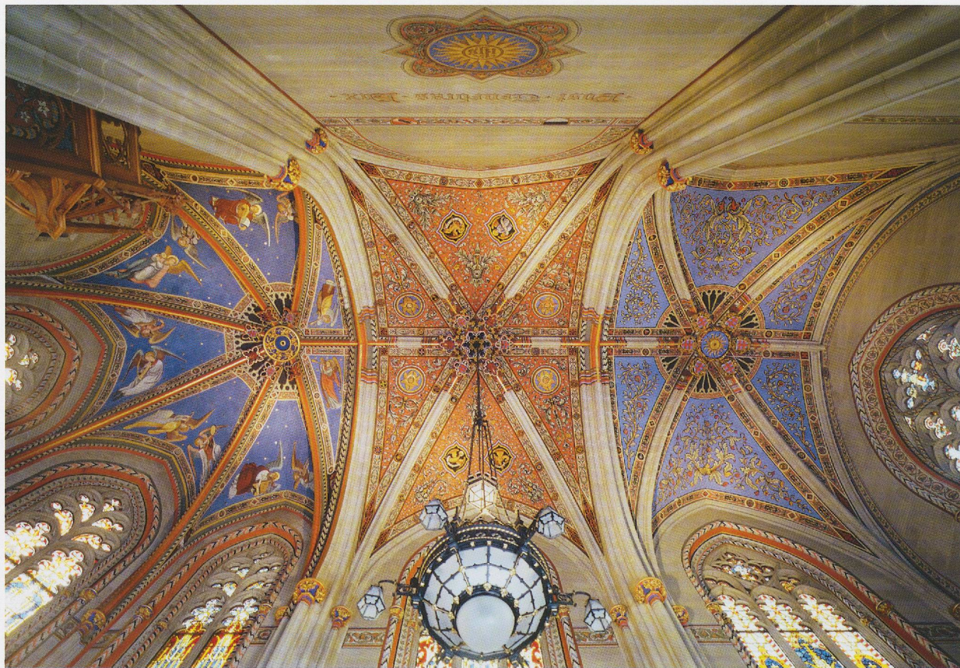
Fig. 72. Genève, chapelle des Macchabées. Ensemble des voûtes à liernes faîtières. Etat en 2004, avec la peinture restituée par Gustave de Beaumont (photo Mathias Thomann, rédaction MAH, Genève). Voir le plan indicatif de la fig. 46.
