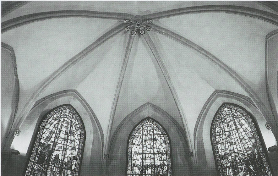
Fig. 96. Sainte-Marie-Madeleine à Genève. La voûte du sanctuaire achevée peu avant 1446 aux frais de Jacques de Rolle, qui plaça ses armes à la clef et à la naissance des nervures (photo MG, 2012).
