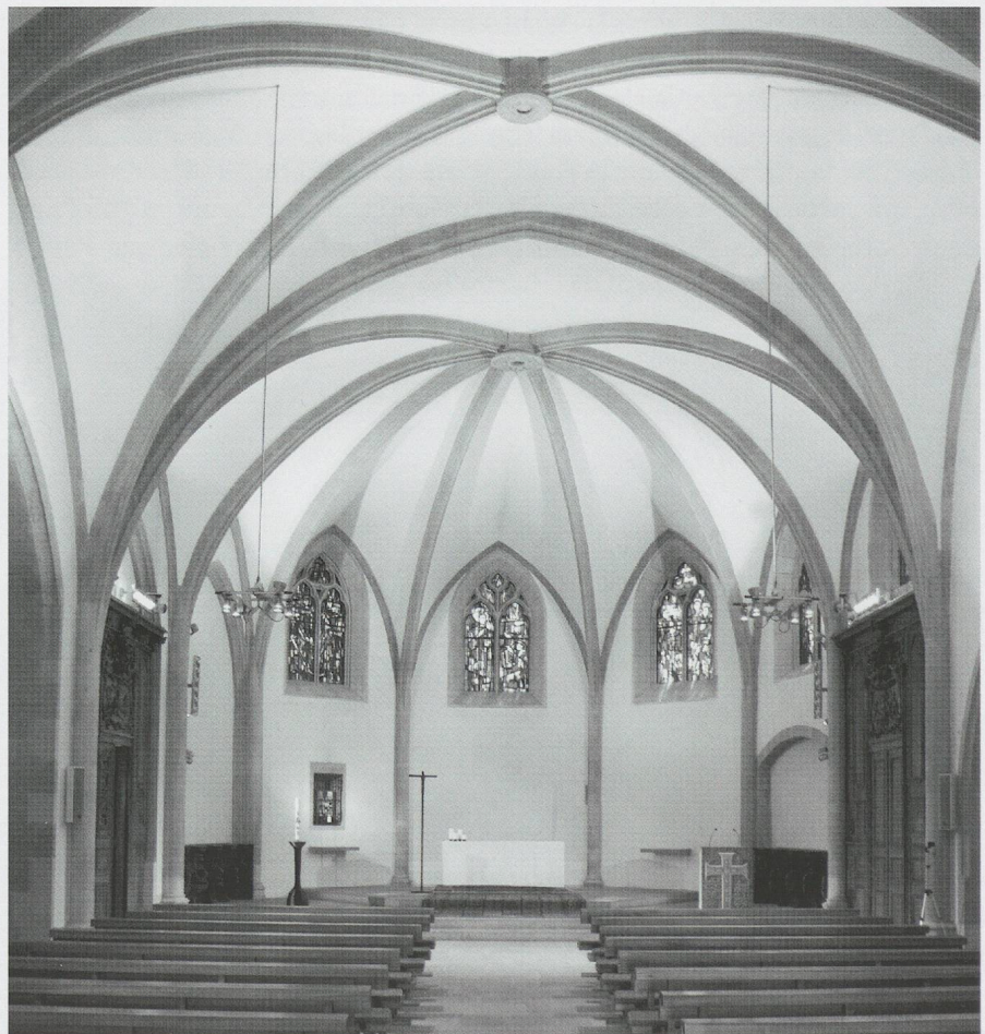
Fig. 116. L'église Saint-Germain à Genève, œuvre des maçons-architectes Pierre de Domo, «maçon maître de l'œuvre de la Fabrique de Saint-Germain» en 1460, et Jaquemet Paillard. L'intérieur vu vers le chœur (photo MG, 2013).
