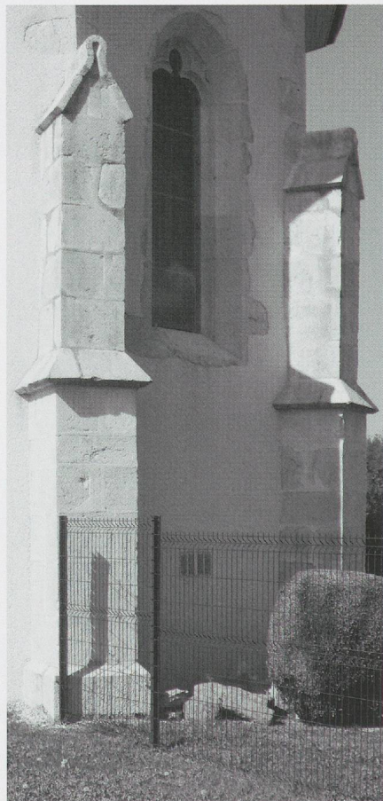
Fig. 189. L'église paroissiale d'Arenthon en Faucigny (peu avant 1516): deux des contreforts en bâtière à pli faitier au chevet du chœur (photo MG, 2013).
