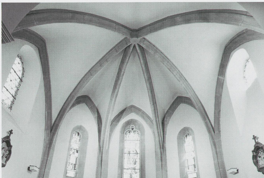
Fig. 188. L'église paroissiale d'Arenthon en Faucigny (peu avant 1516): la voûte du chœur «allongé» (photo MG, 2013).
