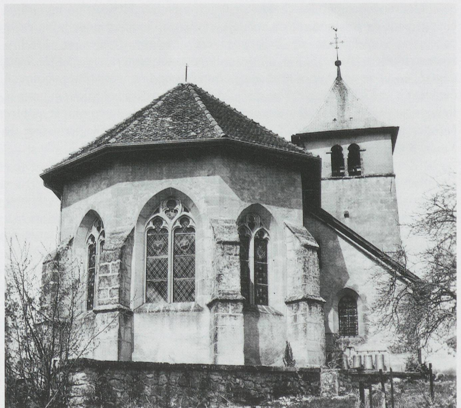
Fig. 206. L'église Saint-Martin de Cernex. Le chevet du chœur et sa couronne de contreforts «genevois» (photo MG, 1982).
