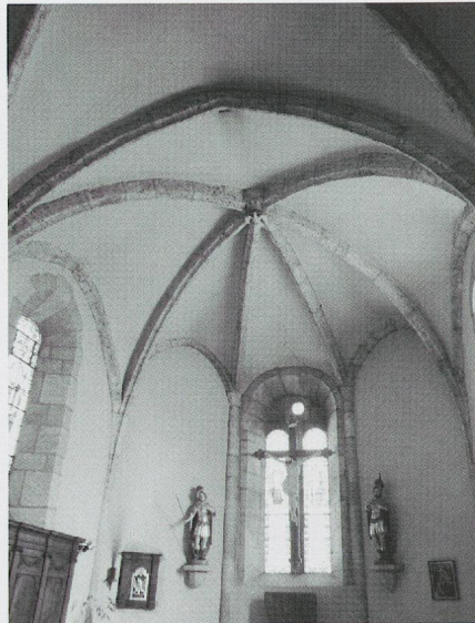
Fig. 200. L'église Saint-Germain de Mieussy, en Faucigny. Les voûtes du chœur, 1471/1481, avec transformation tardive de la fenêtre axiale (photo MG, 2010).
