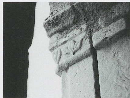
Fig. 197. L'église de Cernex. Chapiteau d'une baie au beffroi du clocher, après 1414 (photo MG, 1965).
