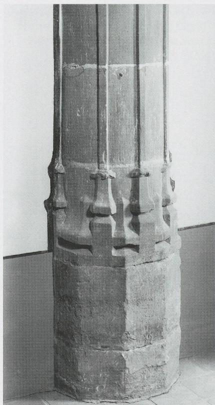
Fig. 313. L'église des Dominicains de Coppet (vers 1492–1494). Une base de colonne engagée de la nef (photo Claude Bornand, 1994).
