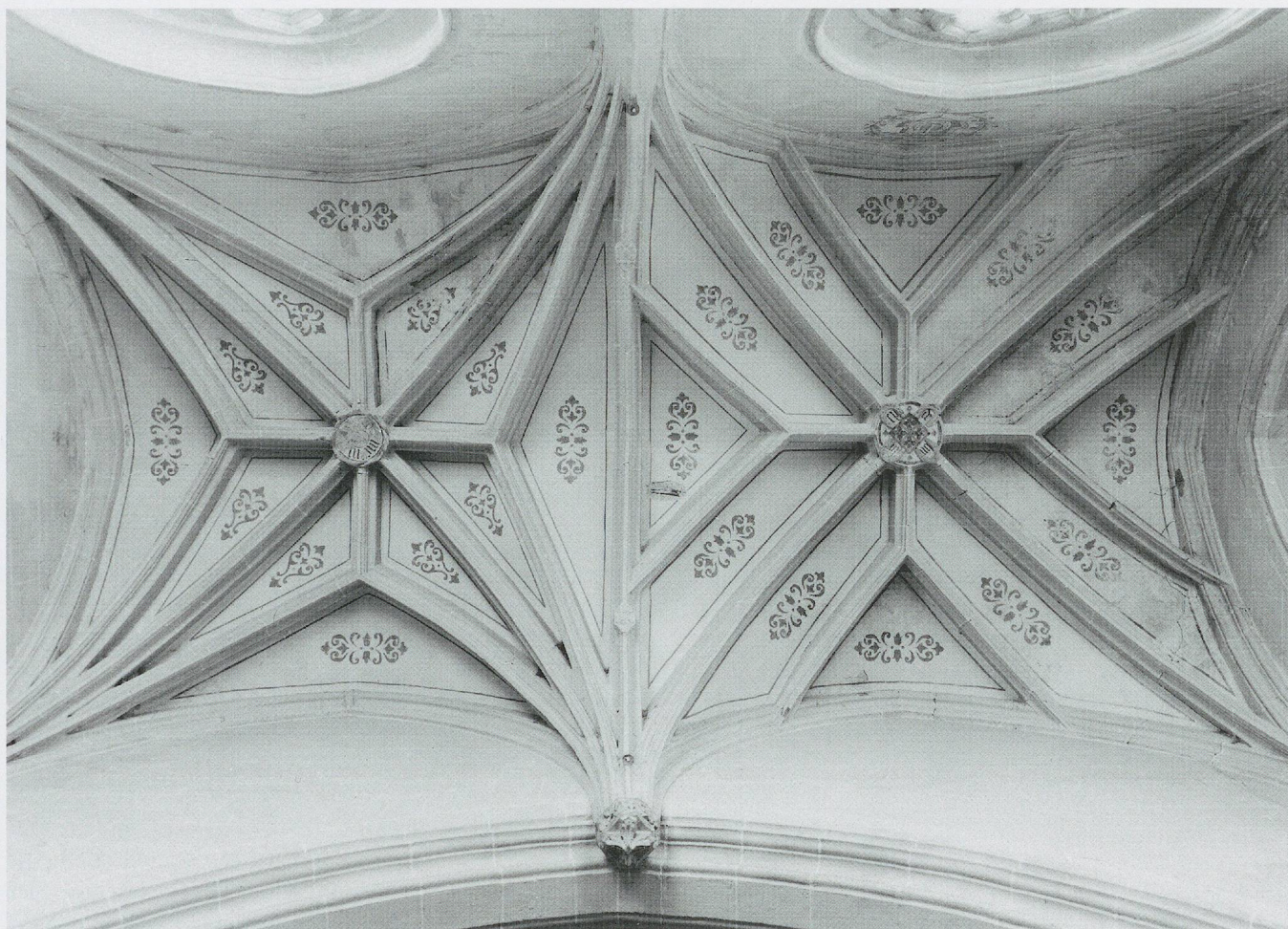
Fig. 360. L'église Saint-Etienne de Moudon: les voûtes à réseau de la chapelle des Buloz (1522), attribuable à François de Curtine (photo Claude Bornand, 1970).
