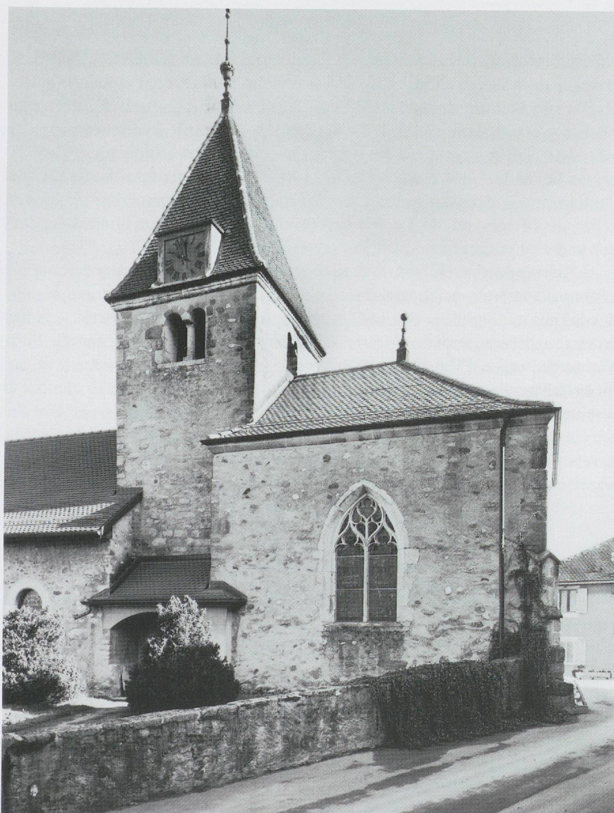
Fig. 556. L'église Saint-Léger de Bavois. Le chevet vu du sud, avec son contrefort «jurassien» conservé et sa fenêtre flamboyante «comtoise» (photo Claude Bornand, 2011).
