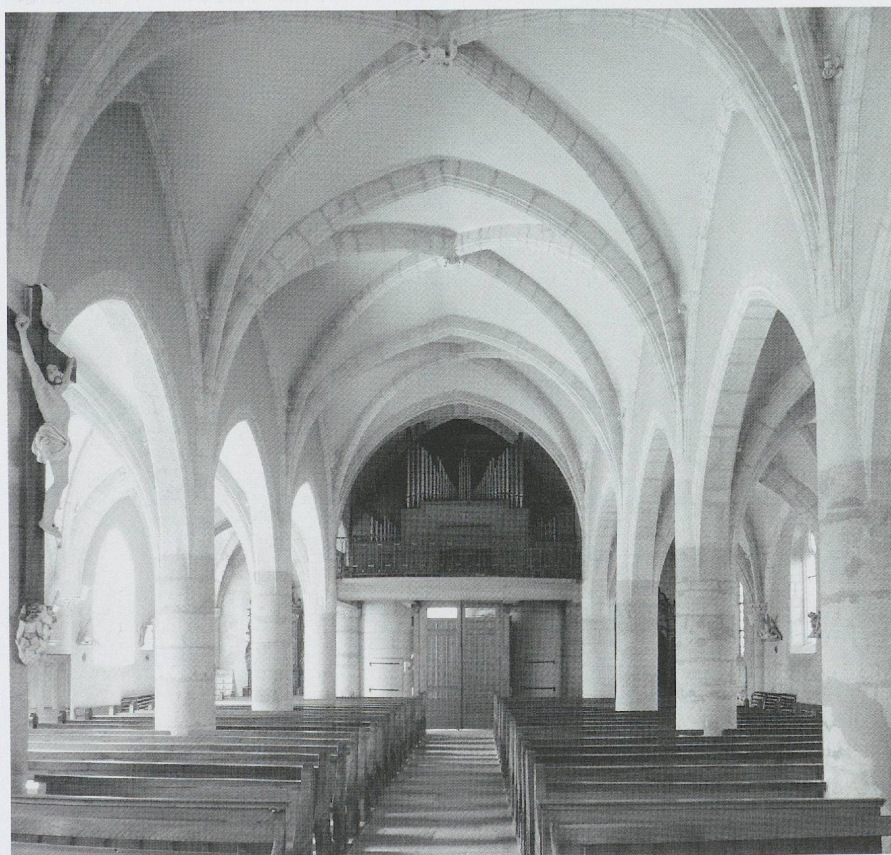
Fig. 606. La paroissiale Saints-Pierre-et-Paul d'Orchamps-Vennes (1520–1566). L'intérieur vers l'ouest (photo MG, 2011).
