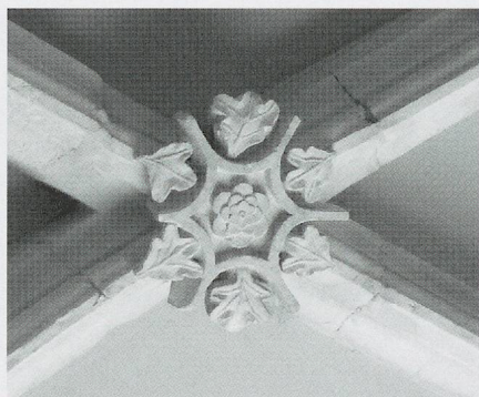
Fig. 616 a. L'église de Sombacour (1493).
