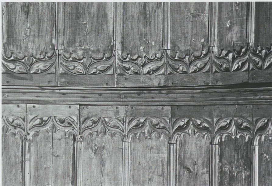
Fig. 680 b. L'église paroissiale Notre-Dame de Môtiers au Val-de-Travers. Détail du décor menuisé du berceau lambrissé (photo OPMS, Neuchâtel).
