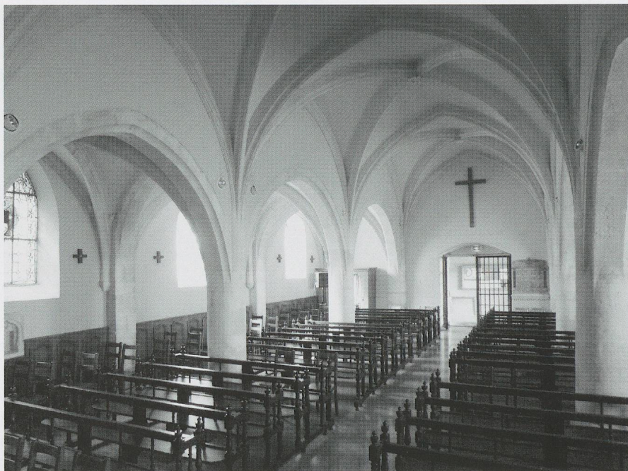
Fig. 607. Saint-Gervais de Sombacour. La nef à collatéraux et simples supports cylindriques puis colonnes engagées, vers 1493: vue vers le sud-ouest (photo MG, 2010).
