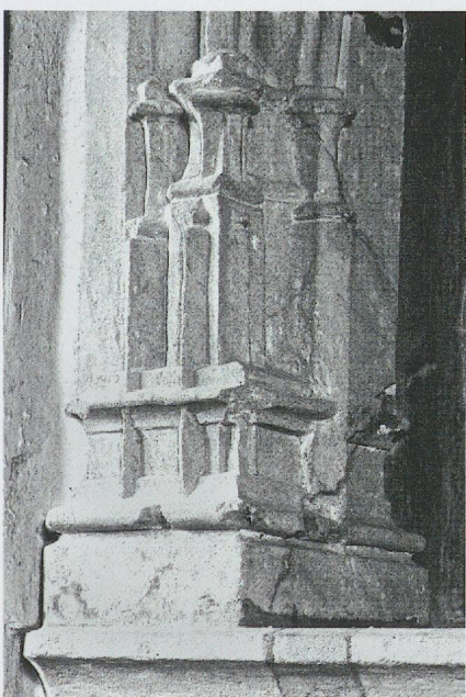
Fig. 753. L'église de Concise VD. La chapelle nord (1510?): la base du piédroit de gauche du lavabo liturgique (photo MG, 2009). Voir aussi fig. 733.
