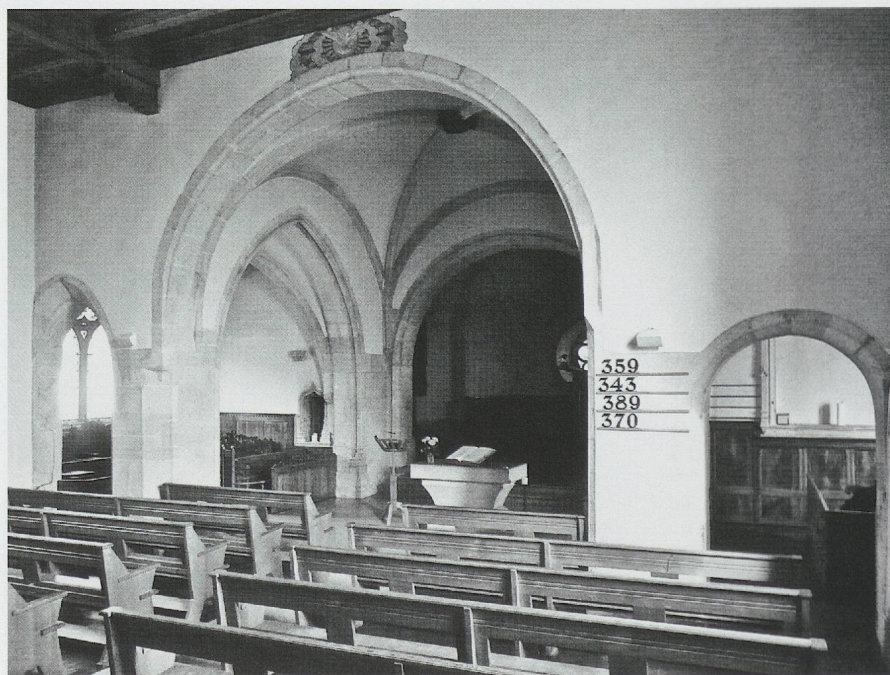
Fig. 732 b. L'église Saint-Jean-Baptiste de Concise. Les ouvertures du «transept», sur la nef (photo MG, 2009).
