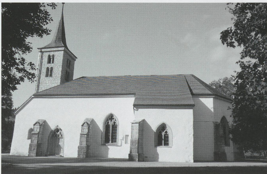
Fig. 713 b. L'église des Verrières. Vue du flanc sud avec ses contreforts de type «jurassien» et la saillie d'une des chapelles de l'avant-chœur (photo MG, 2009).
