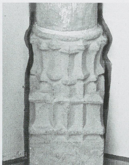
Fig. 723. L'église paroissiale de Gléresse BE. Une base de colonne engagée à imbrication d'éléments «cubiques» de 1520/1523 environ (photo MG, 2011).
