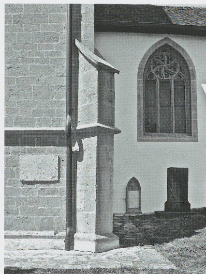
Fig. 769. La Blanche-Eglise de La Neuveville. Le contrefort à talus concave de la chapelle de 1458 et, à l'arrière-plan, la fenêtre sud du chœur, avec rayons ondulés (photo MG, 2011).
