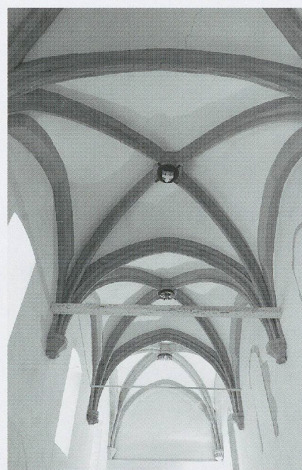
Fig. 789 a et b. L'abbaye de Saint-Maurice d'Agaune. La chapelle de Félix V (vers 1439/1444), sur l'ancien bas-côté sud de l'église romane: clef aux armes du pape Félix V et vue des voûtes (photos Jacques Lathion).
