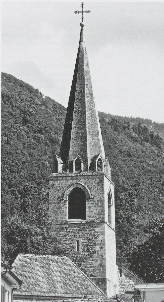
Fig. 806. L'église Saint-Martin de Vollèges. Le clocher, après 1456–après 1507, attribuable à Jean Vaulet-Dunoyer: vue en plongée (photo Guy Turro, 2011).
