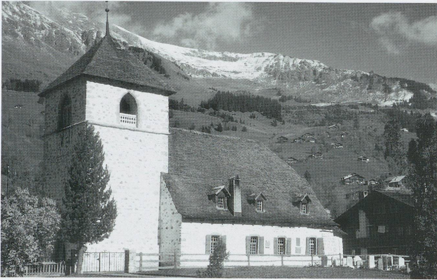
Fig. 796. L'église Saint-Théodule d'Ormont-Dessus à Vers-l'Eglise, filiale d'Ormont-Dessous (Cergnat), consacrée en 1456 par l'évêque de Sion, sans doute après sa reconstruction. Vue du sud-ouest (photo MG, vers 1980).
