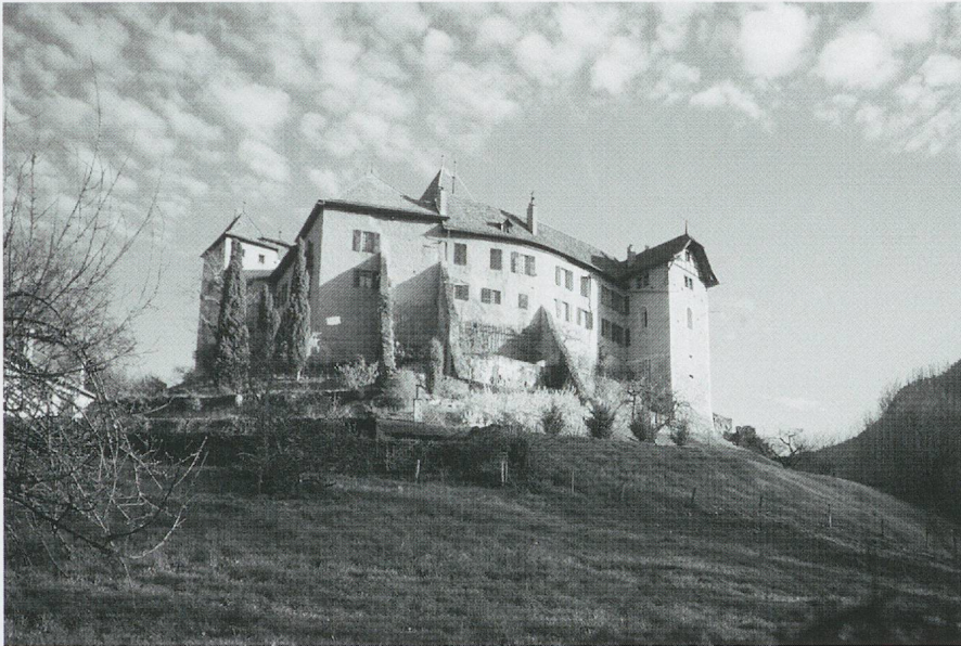
Fig. 946. Le château de Blonay. Au deuxième étage de la tour de droite, les fenêtres de la chapelle Saint-Nicolas (photo Daniel de Raemy, 1994).
