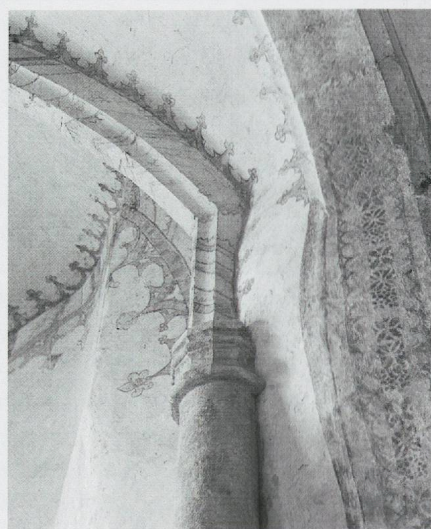
Fig. 950. L'abbatiale de Romainmôtier. La chapelle de Jean de Juys (1444/1445): détail d'une colonne engagée au milieu du mur sud (photo MG, 1973).
