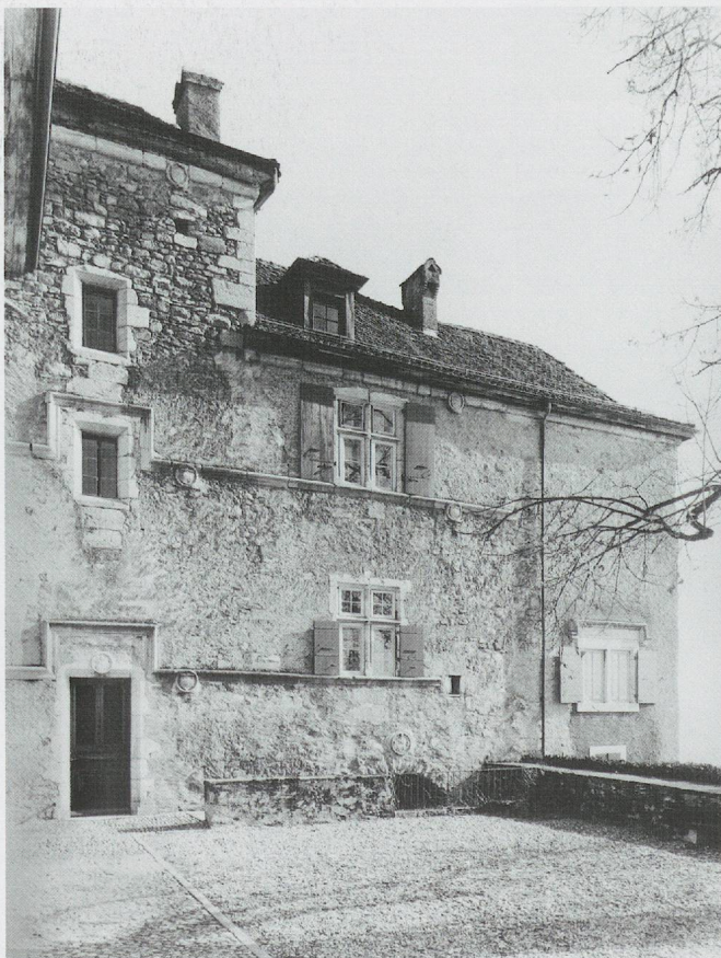
Fig. 985. Le château de Glérolles à Lavaux. La face donnant sur le lac de l'aile sud reprise par son neveu Sébastien: l'angle de gauche résulte d'une restauration, celui de droite est à bossage, cas rare (photo Claude Bornand, 1972). Voir fig. 388 et 973.
