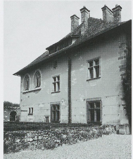
Fig. 966. Le château ducal de Ripaille (Haute-Savoie). La chapelle d'Aymon de Montfalcon, prieur, à l'étage de la tour-résidence d'Amédée VIII, de 1497 environ: les deux fenêtres flamboyantes, rénovées, à l'angle du 1 er étage (photo MG, 1988).
