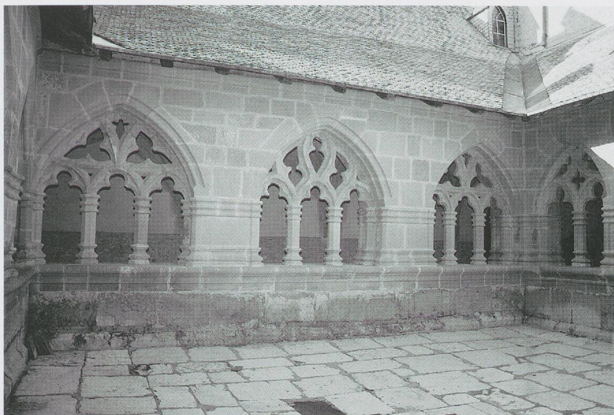
Fig. 1027. Le petit cloître de l'ancienne chartreuse du Reposoir (Haute-Savoie), vers 1530 (?): vue du préau vers le nord-est (photo MG, 1986)
