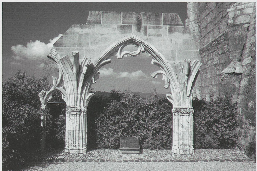
Fig. 1022. L'ancienne abbaye des Prémontrés du Lac de Joux: les vestiges d'arcades du cloître, remontés en 1969–1971 (photo MG, 1985).
