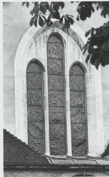
Fig. 996. L'église du couvent des Cordeliers de Cluses, en Faucigny. La fenêtre de la façade ouest, avec triplet à simples lancettes (photo carte postale, détail).
