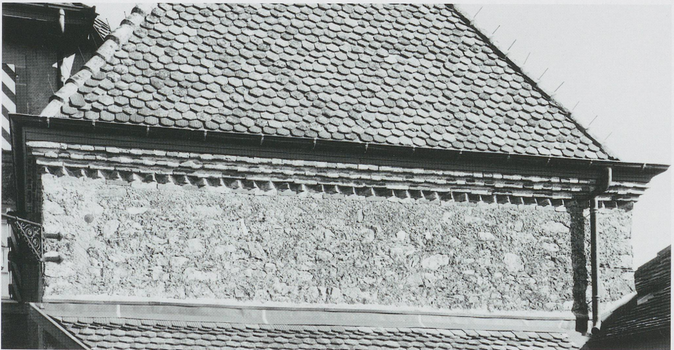
Fig. 1044. La chapelle du Dézaley de l'abbaye de Montheron (commune de Puidoux). La corniche en brique peinte, vue du côté ouest (photo Claude Bornand, 1971).
