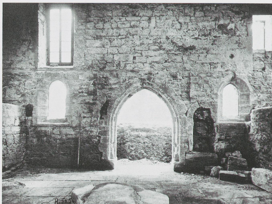
Fig. 1034 a. L'abbaye cistercienne de Montheron (Lausanne): l'ancienne salle capitulaire des XIII e /XVI e siècle, vue vers l'est lors des travaux de 1928 (photo André Kern).
