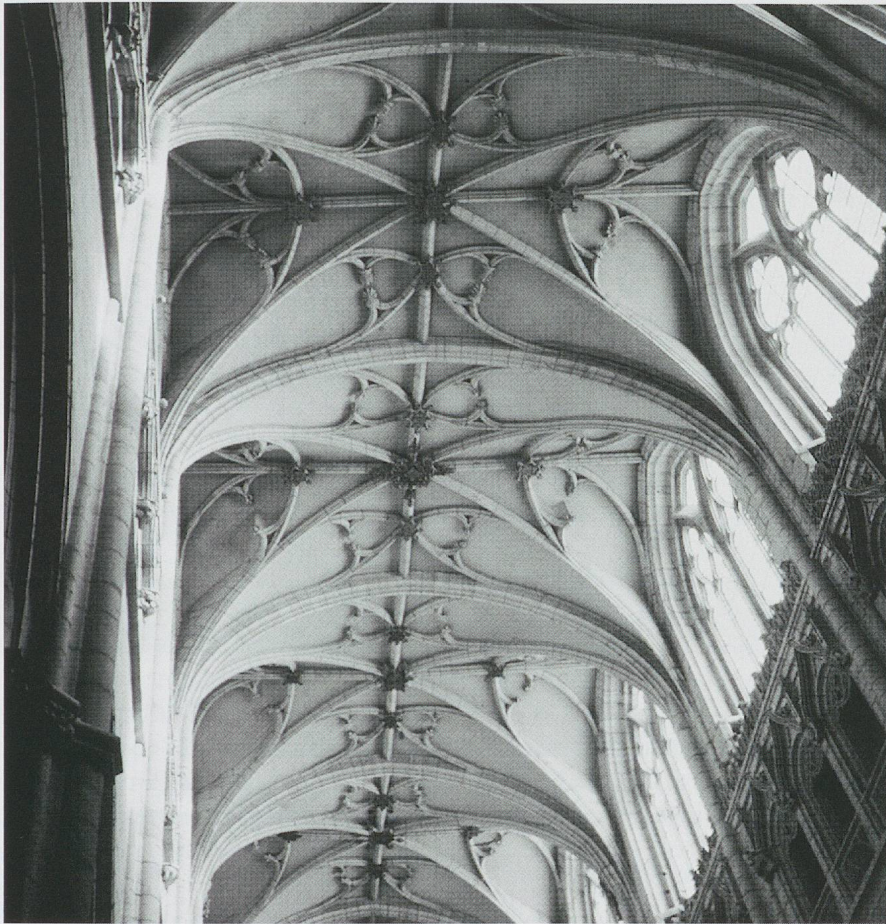
Fig. 1048. L'église Saint-Nizier à Lyon. Les voûtes de la nef (photo MG, 2001).
