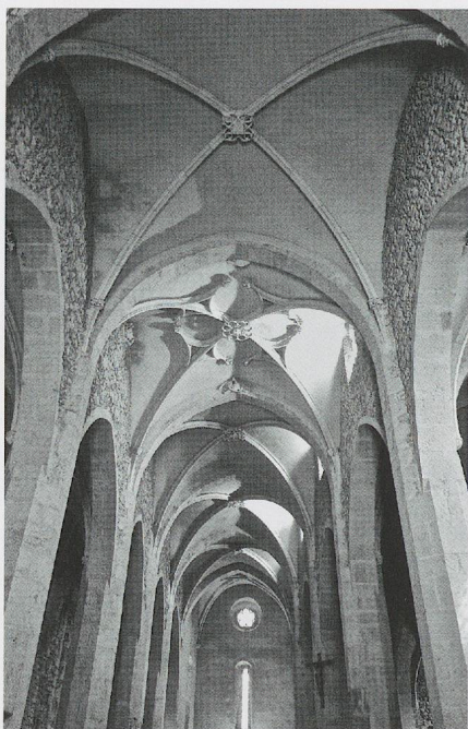
Fig. 1049. L'église de Pérouges (Ain). Les voûtes de la nef, vers 1469 (photo MG, 2010).
