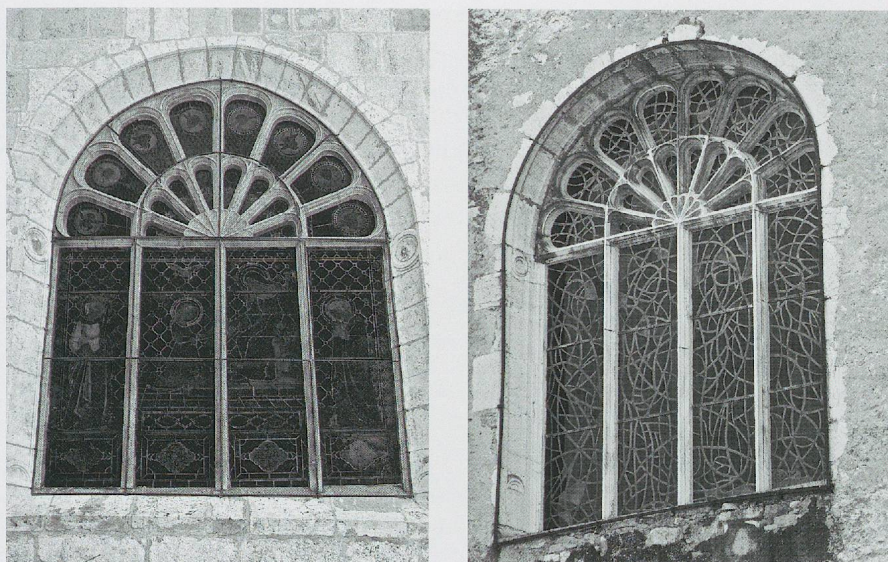
Fig. 1076. L'église abbatiale de Nantua (Ain). La chapelle Sainte-Anne, fondée par la famille de la Forest (1522/1536): la baie Renaissance «florentine» de la face nord (photo MG, 2011).
