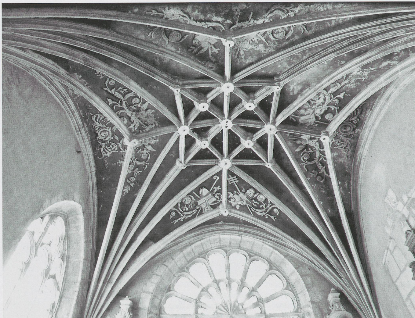
Fig. 1061. L'église abbatiale de Nantua. La voûte de la chapelle de la Forest (1522/1536) (photo MG, 2011).
