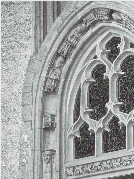
Fig. 1102 c. L'église Saint-Benoît de Bienne. Détail du portail à voussures sculptées des bustes des Pères de l'Eglise (photo MG, 2011). Le remplage est moderne.
