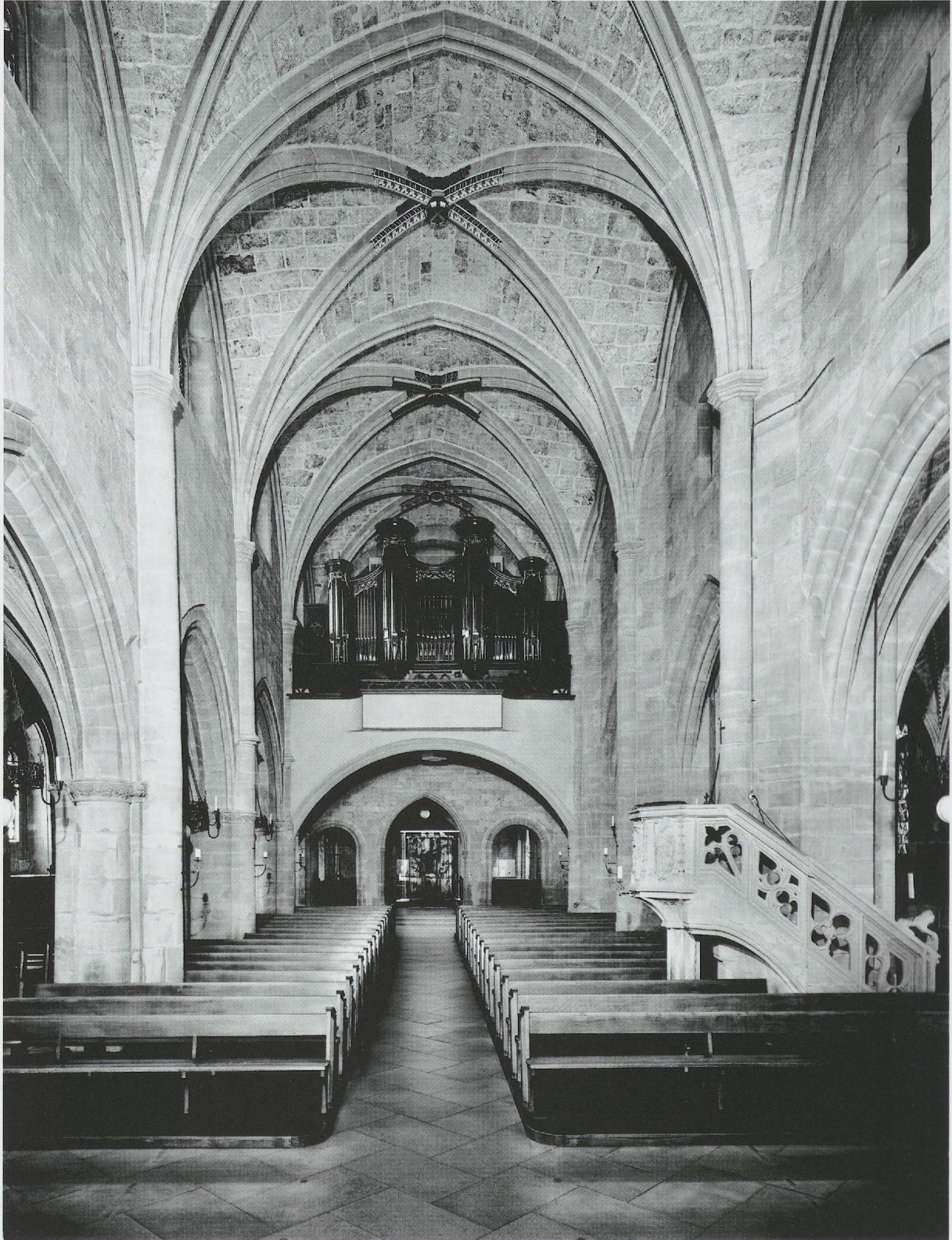
Fig. 850. Notre-Dame de Romont. Vue de l'intérieur de la nef vers l'ouest: au sud, murs commencés au XIV e siècle et au nord, murs dès 1425 et voûtes en 1481-1486 (photo Yves Eigenmann, SBC Fribourg, 1996).
