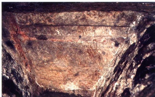
Fig. 140 – Dalle de fond de bassin réutilisée comme linteau pour une ouverture latérale du couloir d'accès des églises paléochrétiennes du Martolet à St-Maurice.
