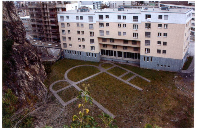
Fig. 202 – Vue du site en juin 2011, avec le premier marquage partiel.
