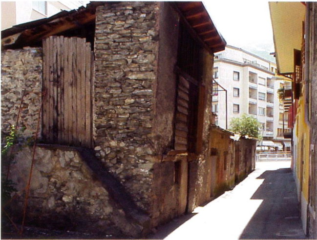
Fig. 199 – Vue des bâtiments de la frange ouest en 2005, avant...
