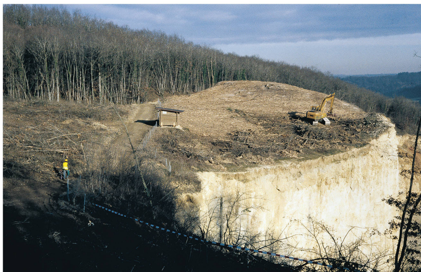
Fig. 20. La partie nord de l'étape 1, vue depuis le sud.
