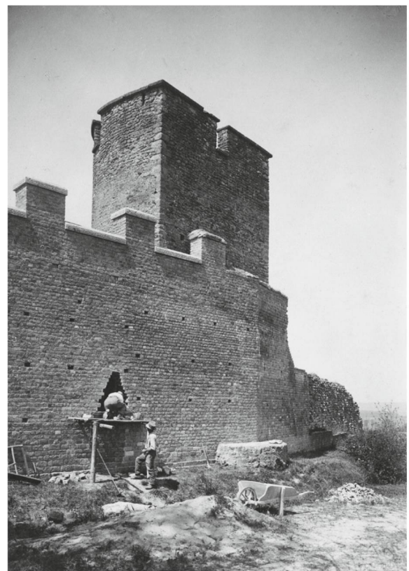
46 Die Mauerbresche an der Kurtinenaussenseite südlich von T2 wird zugemauert (1921).
