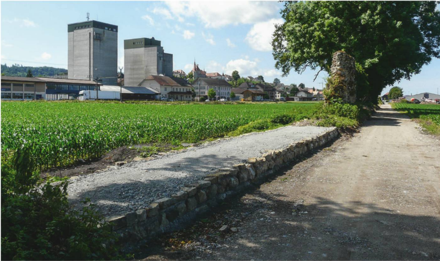
55 Restaurierte Mauerpartie auf dem Teilstück T17–T18_M1 (2009.06).
