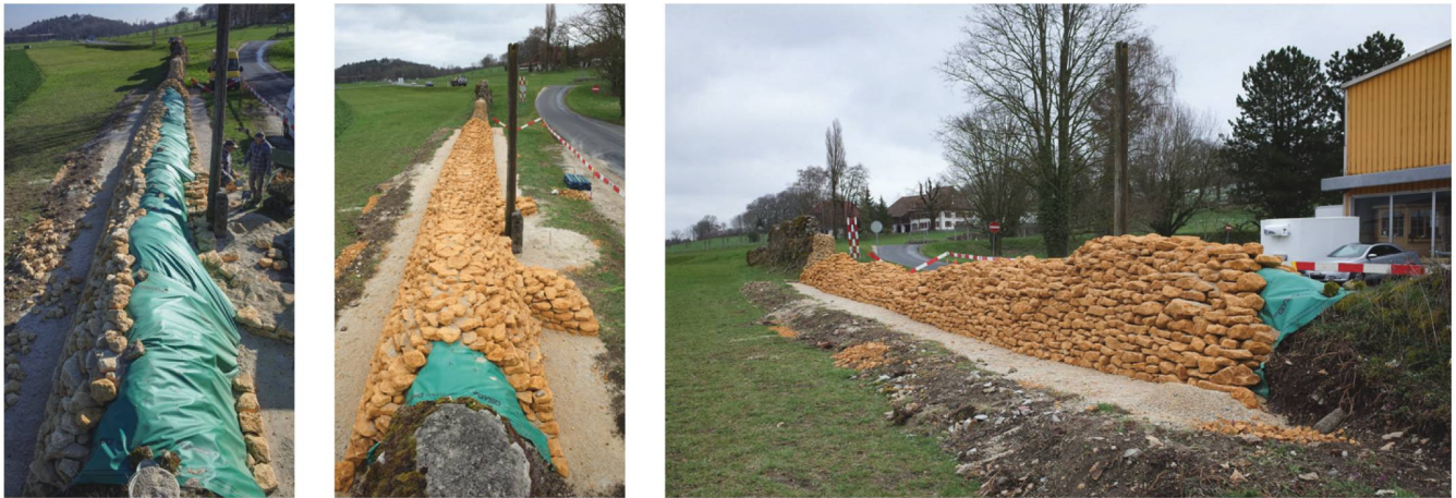
62 Mit neuem Trockenmauerwerk überdeckter, originaler Mauerkerne auf dem Teilstück T8–T9_M1 (2019). Rechts im Bild wird der Grundriss des Turmes T9 markiert. Innerhalb des Turmgrundrisses steht noch die Holzpfosten-Markierung von L. Bosset.
