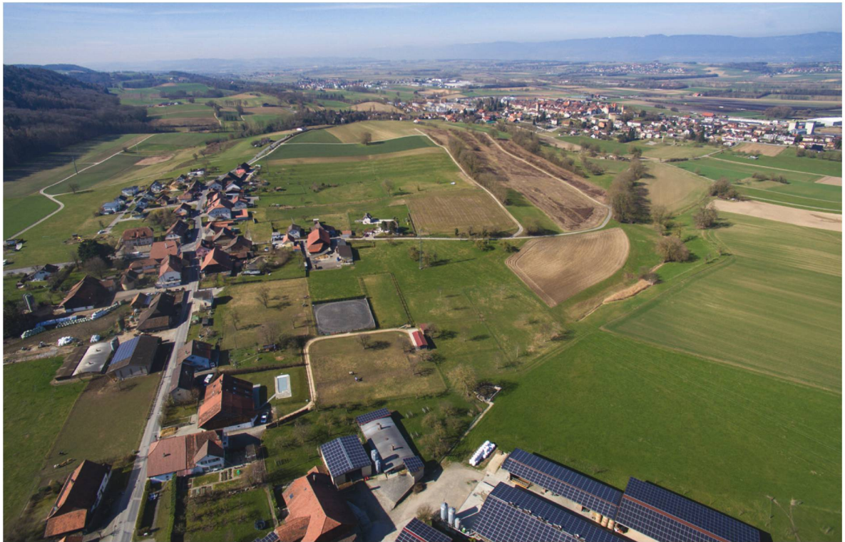
14 Südteil des Stadtgebietes von Aventicum mit dem modernen Dorf Donatyre am linken Bildrand. Die moderne Strassenführung folgt hier dem Verlauf der antiken Stadtmauer. Am linken oberen Bildrand ist der Hangfuss des Bois de Châtel zu erkennen.
