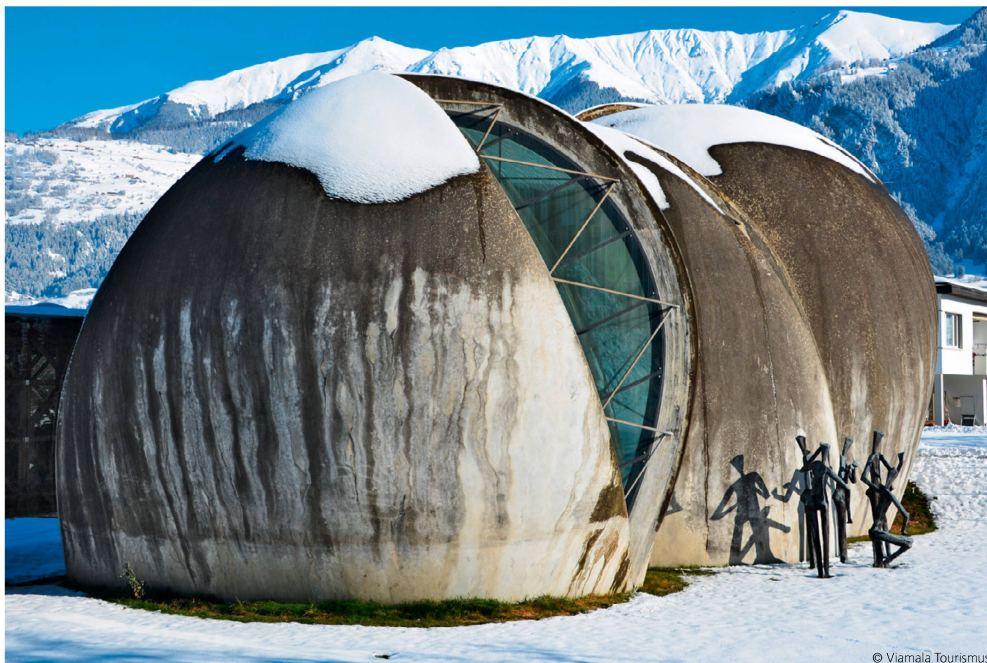
Schalenbau der Steinkirche in Cazis
