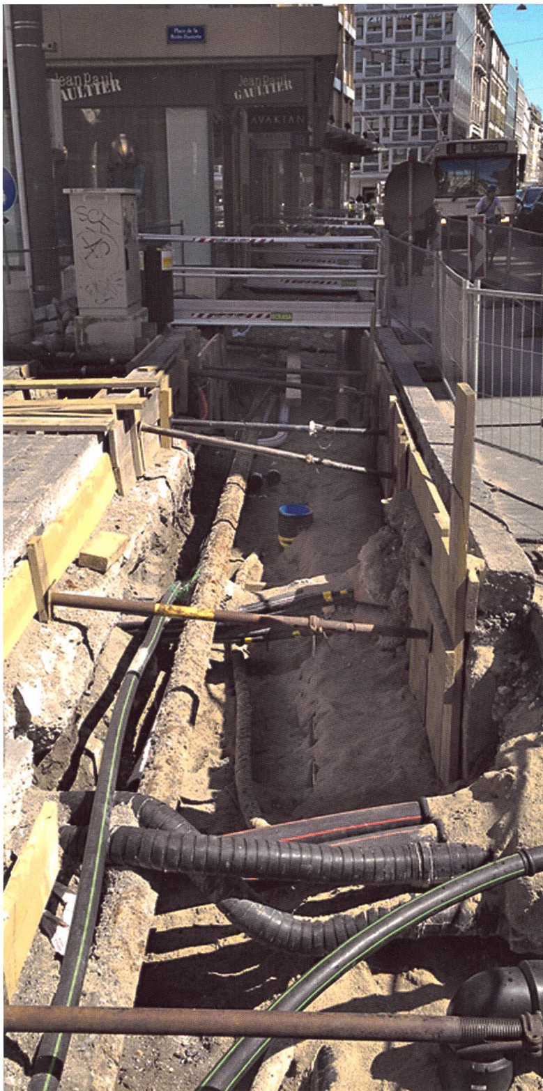
Fig: Complexité du sous-sol
